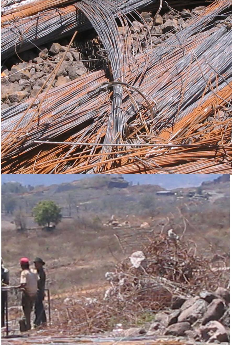
Figura 39. Daño en las estibas de varillas de acero derivado de la falta de equipo y de la inadecuada operación de descarga en los almacenes. (Fuente:propia)
