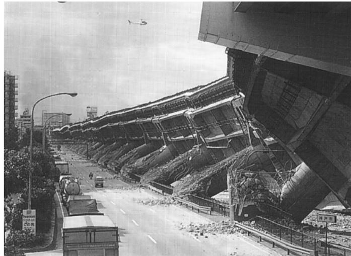
**Figura 1.2. Falla de pilas del puente Hanshin expressway, Kobe 1995**
