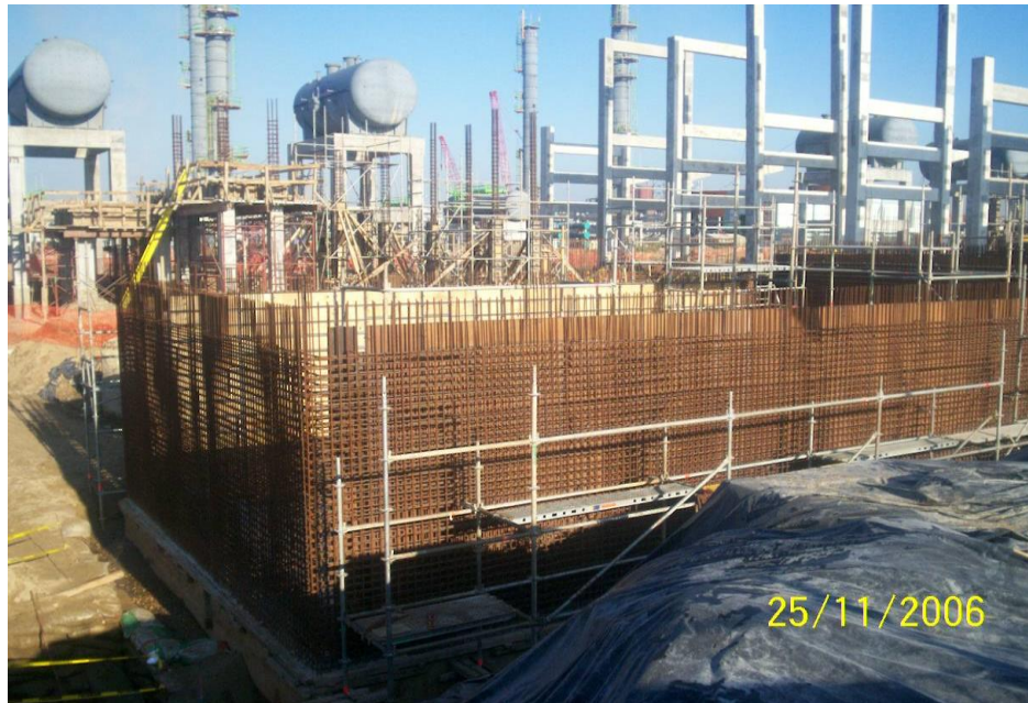
Fotografía 7.22.- Colocación y armado de muros de las fosas de azufre.
