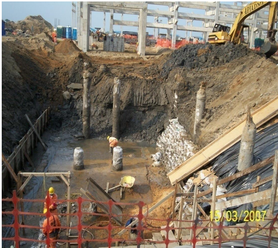
Fotografía 7.15. - Excavación profunda para la fosa de aguas acidas.
