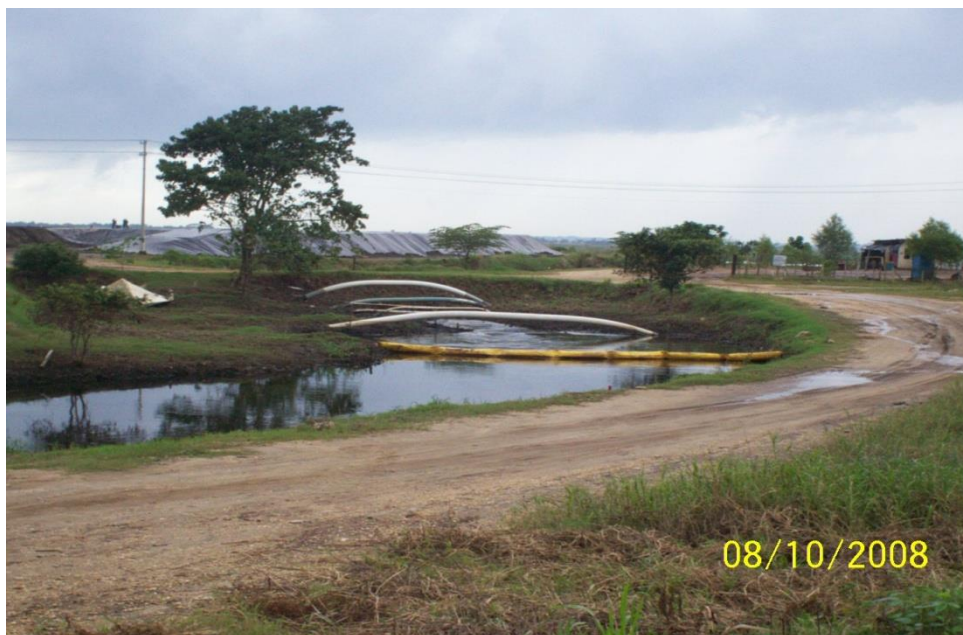
Fotografía II.2.- Colocación de barreras de protección en los arroyos que descargan al río Coatzacoalcos.
