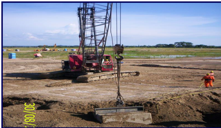
Fotografía.7.1.- Trazo de un área para la ejecución de la compactación dinámica.
