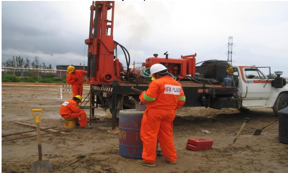
Fotografía. III.1.- Ejecución de sondeo de cono eléctrico en áreas nuevas
