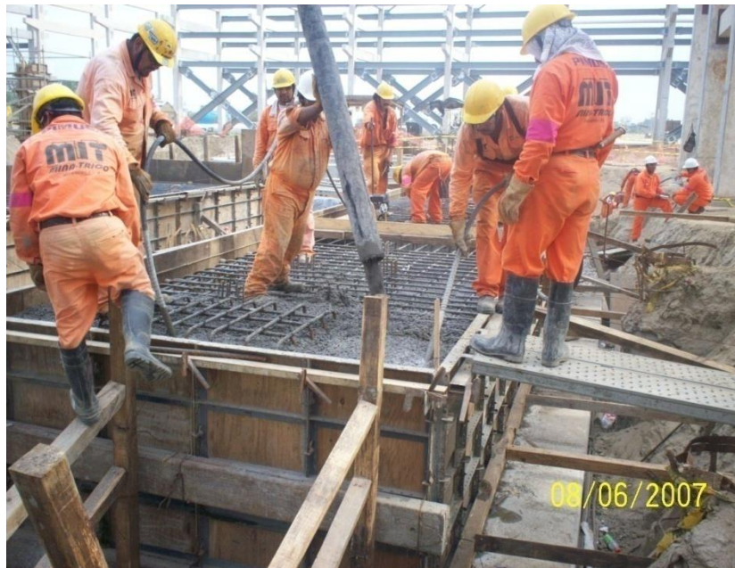
Fotografía 7.33.- Colocación de concreto en bases de equipos.
