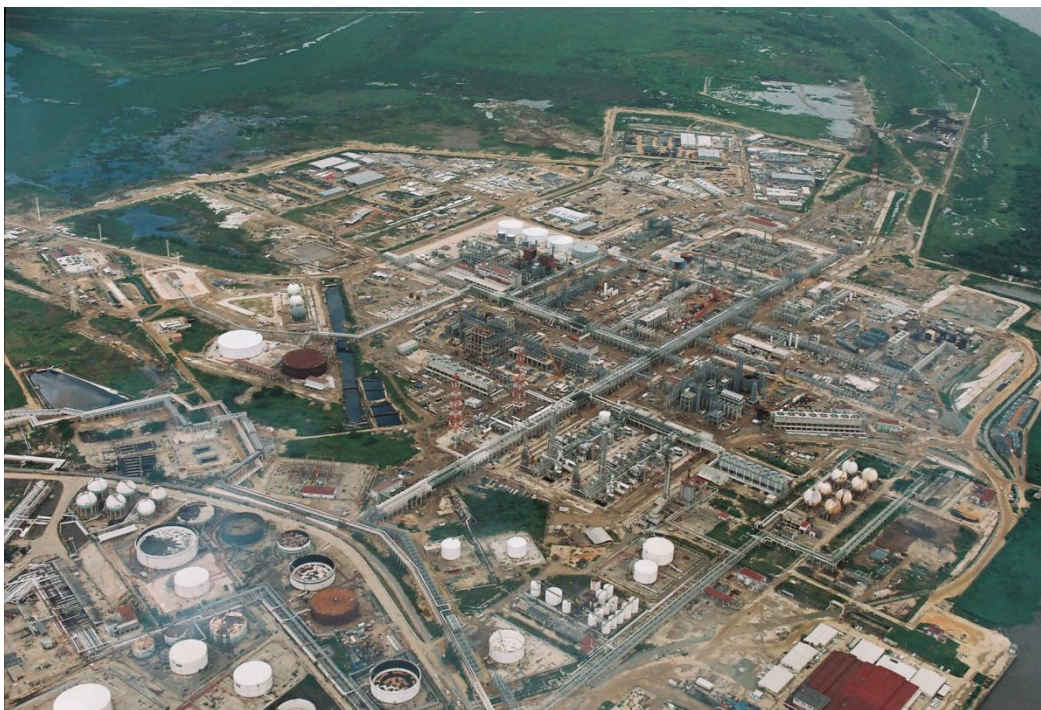
Vista aérea de la reconfiguración de la refinería Lázaro Cárdenas
