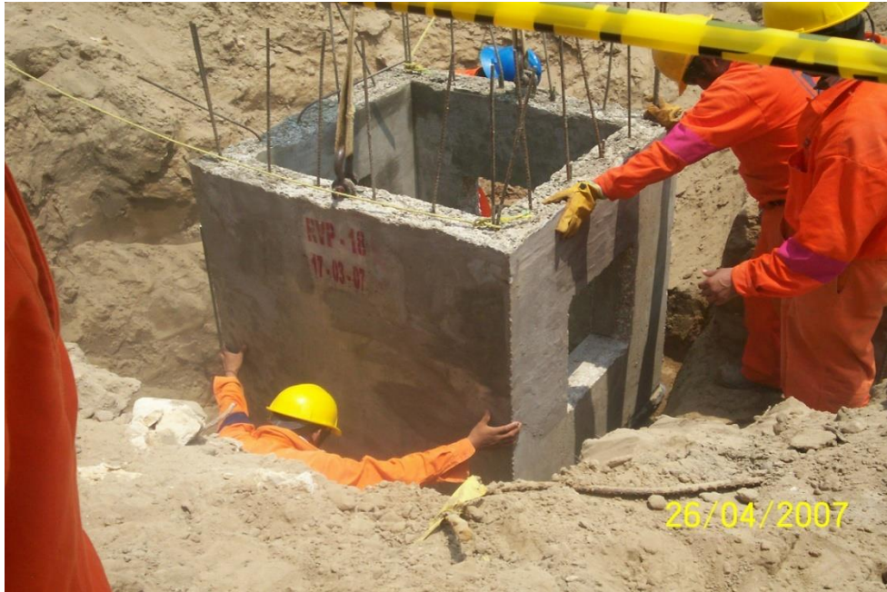
Fotografía 7.40. - Instalación y colocación de registro de visita pluvial.
