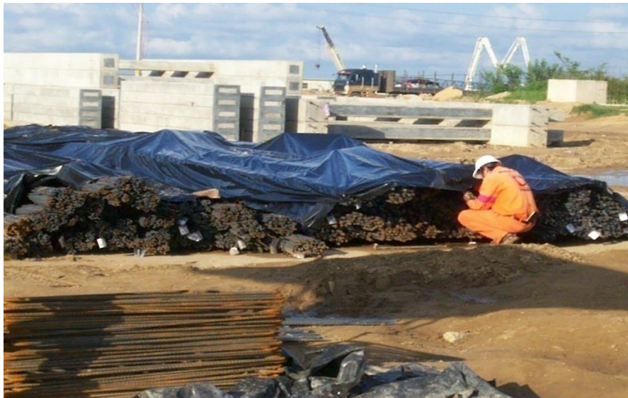
Fotografía 7.18- Almacenamiento de acero de refuerzo por diámetro de barras.
