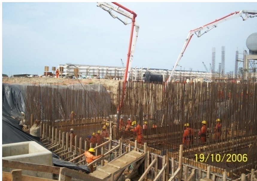
Fotografía 7.32.- Colocación de concreto en losa de cimentación de las fosas de azufre.
