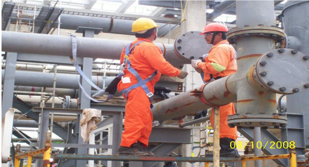
Fotografía 8.3- Equipo de protección personal para trabajos en altura.
