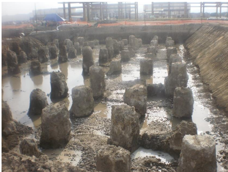
Fotografía 7.11 Pilas listas para descabece
