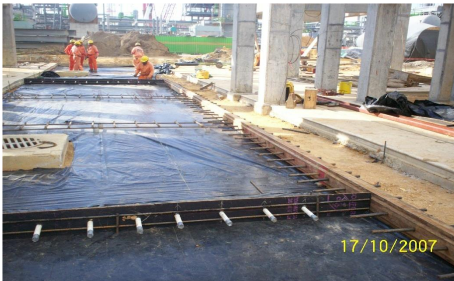
Fotografía 7.48.- Colocación de cimbra y acero de refuerzo en pavimentos.
