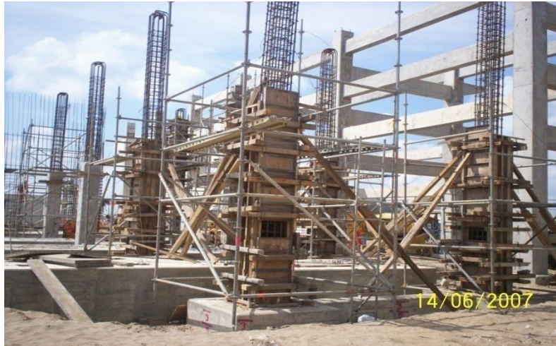
Fotografía 7.25.- Colocación de cimbra en elementos esbeltos.
