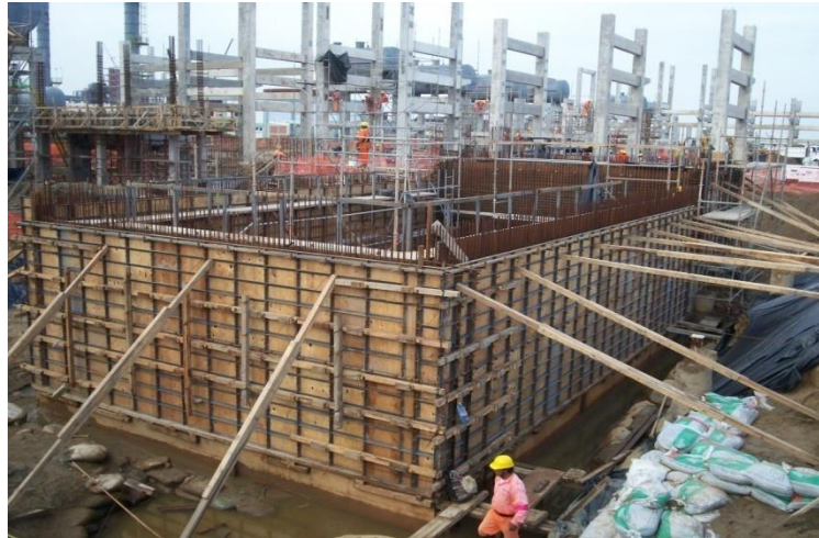
Fotografía 7.26.- Colocación de Cimbra Modular en Muros de la Fosa de Azufre.
