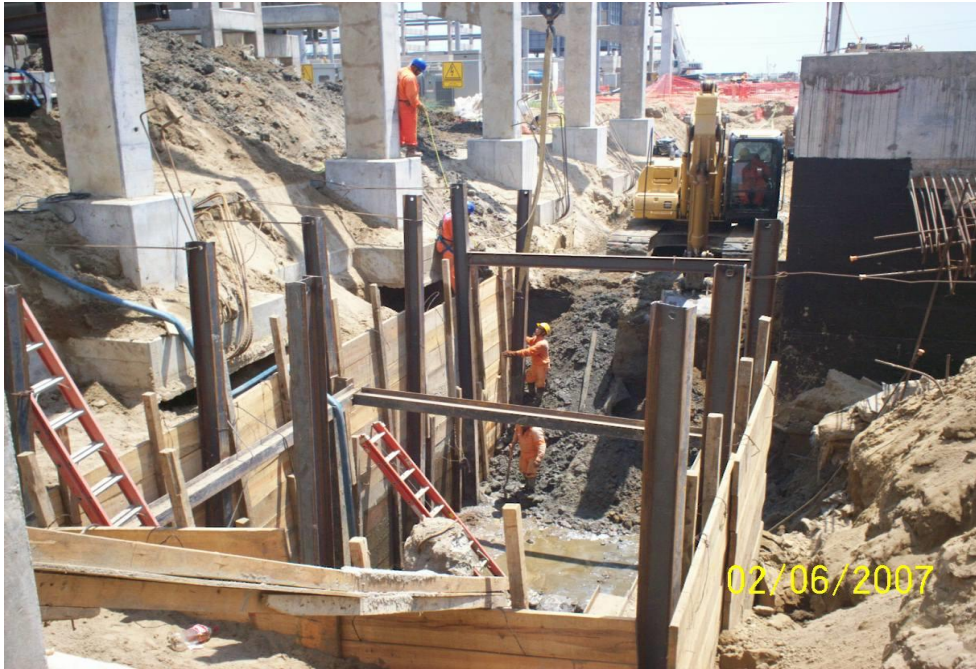
Fotografía .7.14- Excavación Ademada para la Construcción de los Sellos de Azufre.
