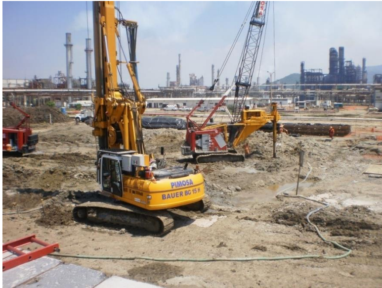
Fotografía 7.8.- Perforación de Pila
