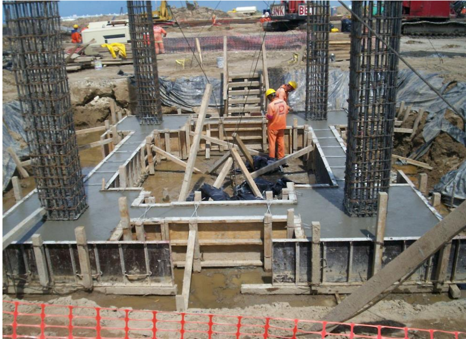
Fotografía 7.34. Curado de concreto en zapatas y contra trabes.
