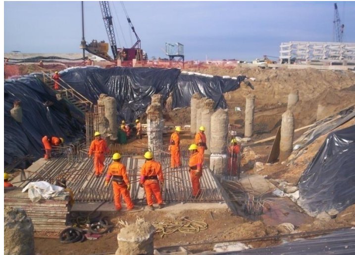
Fotografía.7.20.- Colocación de acero de refuerzo en losa de cimentación de las fosas de azufre
