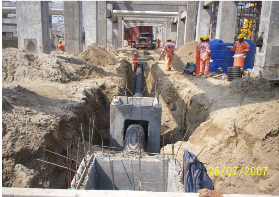
Fotografía 7.41. - Instalación y colocación de tubería de polietileno
