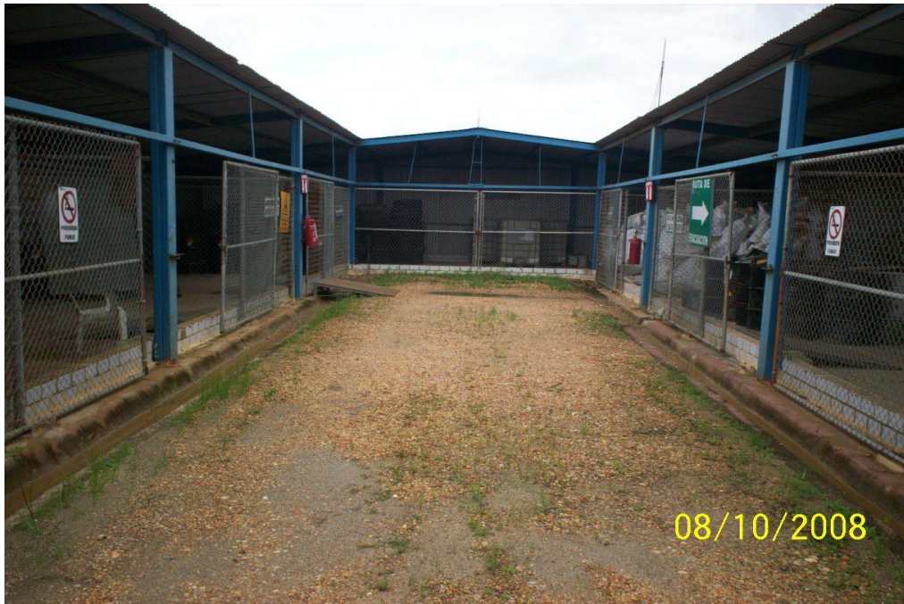
Fotografía. II.3.- Almacén temporal de residuos peligrosos.
