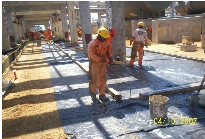
Fotografía 7.47- Colocación de polietileno
