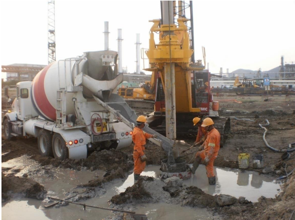
Fotografía 7 .12. - Vaciado de Concreto en Pila.
