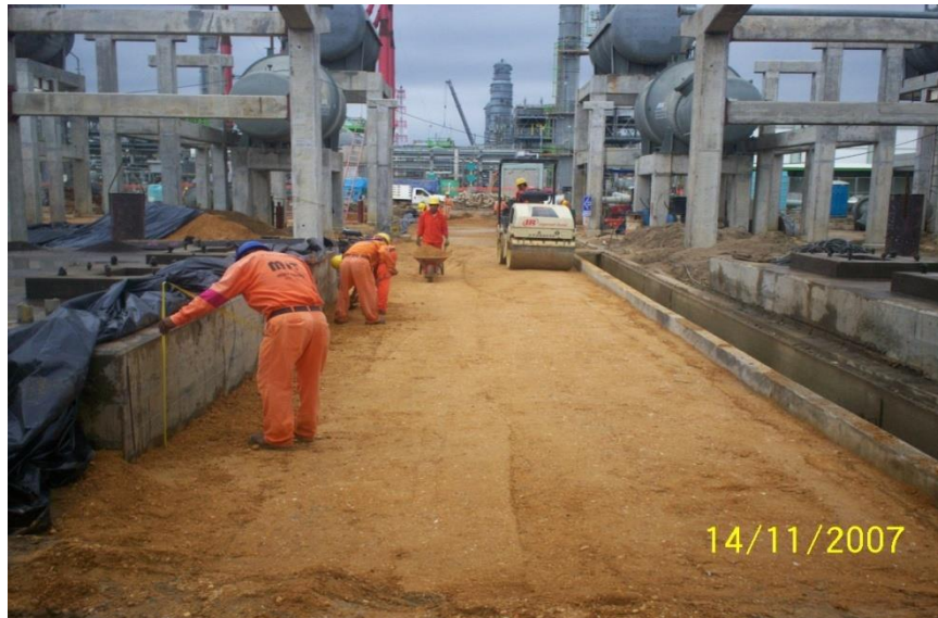
Fotografía 7.46.- Tendido, compactación y verificación de niveles de Sub-base.
