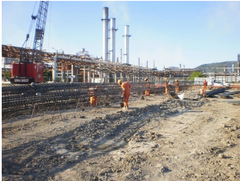
Fotografía. 7.9. - Habilitado y Armado de Acero de Refuerzo de Pilas.
