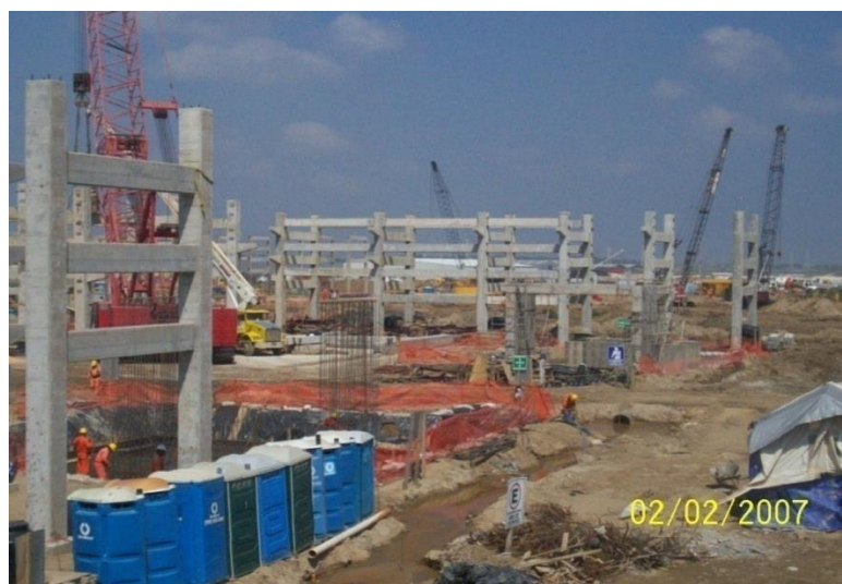
Fotografía 8.6.- Instalación de sanitarios portátiles en las inmediaciones de la obra.
