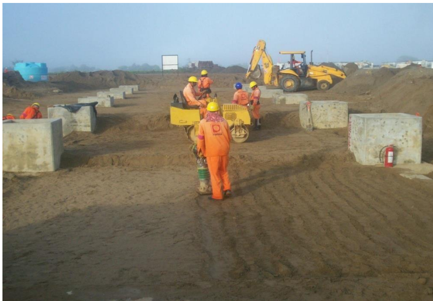
Fotografía 7.36.- Relleno y Compactación en el Rack Secundario de Tuberías.
