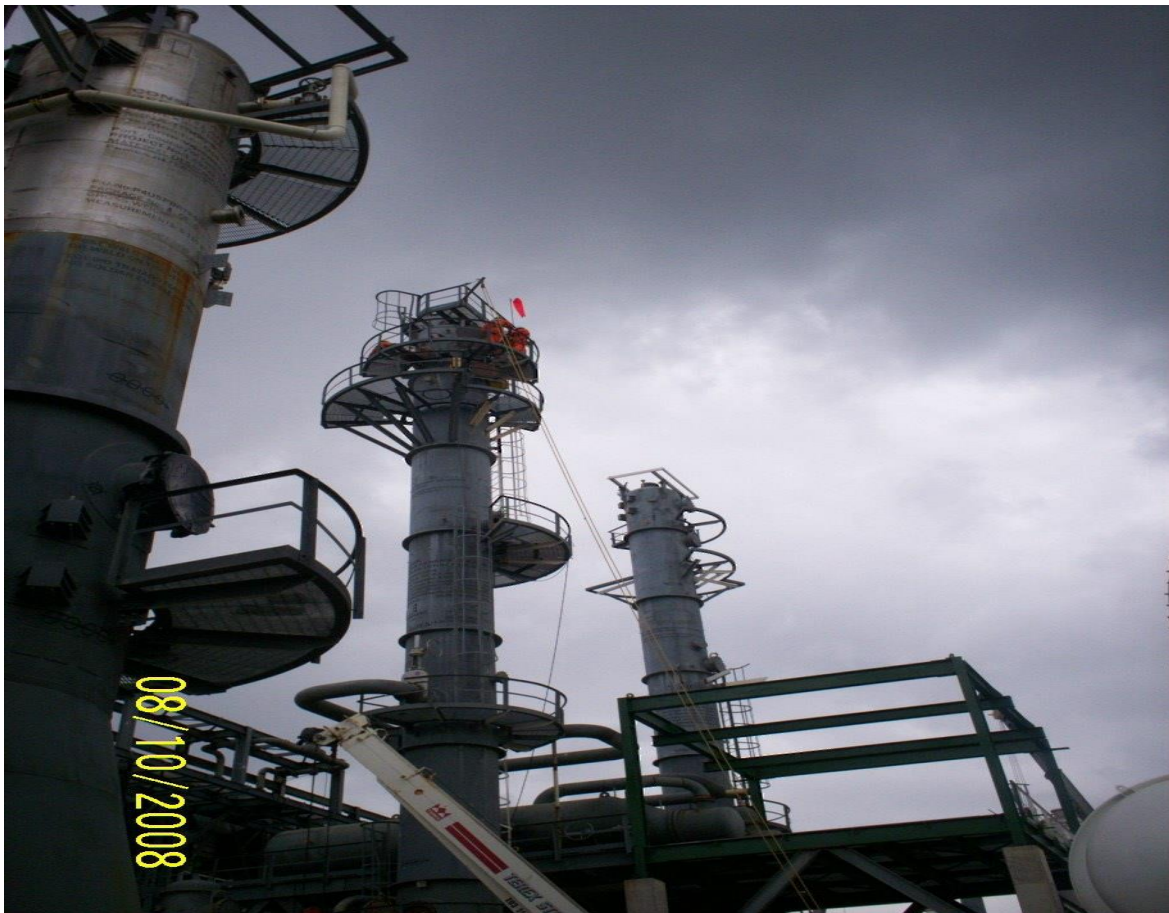
Fotografía 8.11.- Personal laborando en alturas con su equipo contra caída
