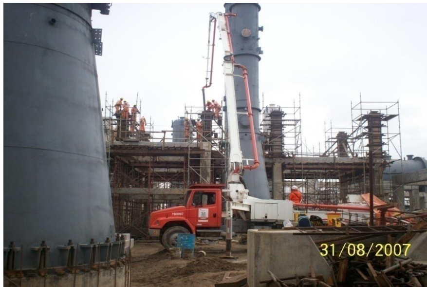
Fotografía 7.33.- Colocación de concreto en elementos esbeltos.
