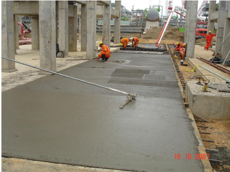
Fotografía 7.49.- Colocación, tendido y enrasado de concreto hidráulico.
