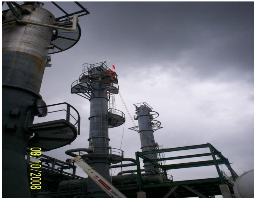
Fotografía. 8.4.- Personal laborando en alturas con su equipo contra caídas.
