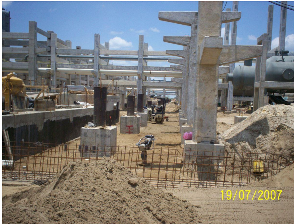
Fotografía 7.38.- Relleno y compactación con medios mecánicos en el área de los sellos de azufre.
