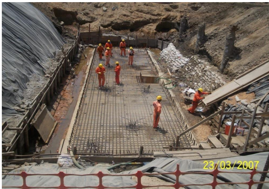
Fotografía. 7.19.- Colocación de acero de refuerzo en fosas.
