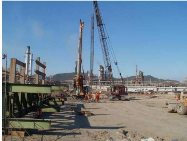
Fotografía 7.10.- Colocación de Acero de Refuerzo en Pila.
