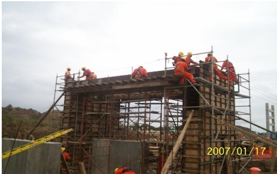
Fotografía 7.27.- Colocación de cimbra modular en muros y trabes..
