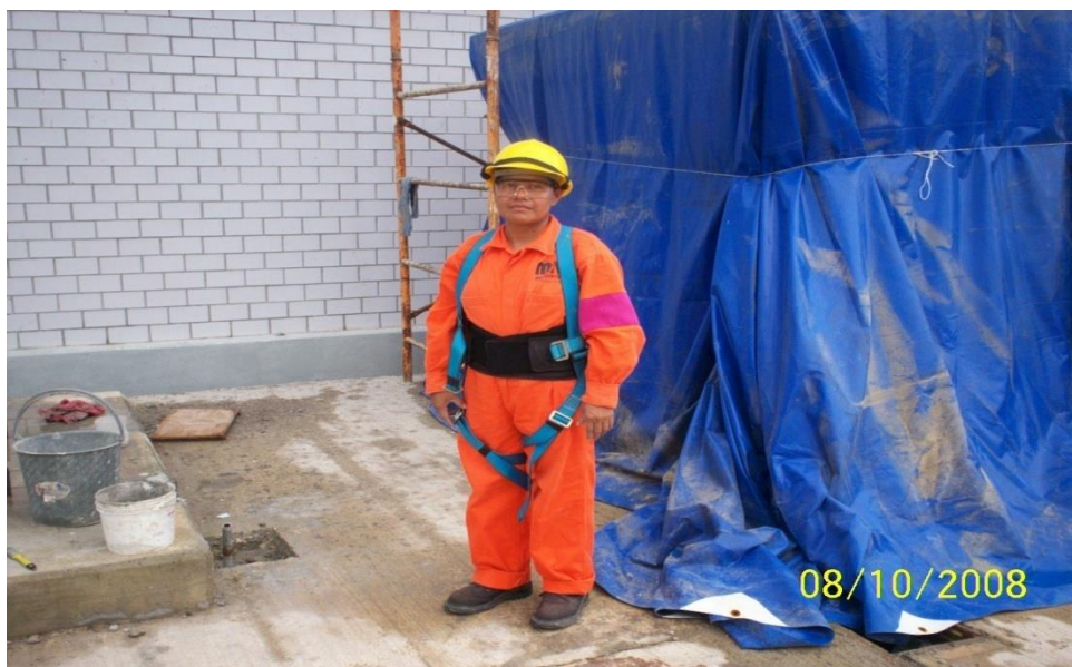
Fotografía 8.1.- Uso del equipo de protección personal
