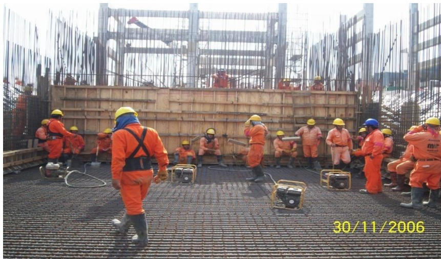
Fotografía 7.31.- Revisión del equipo de vibración antes de la colocación de concreto
