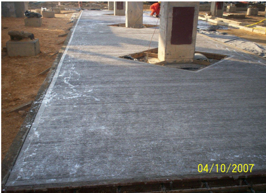
Fotografía 7.51- Curado de concreto en pavimentos.
