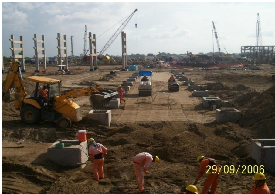
Fotografía 7.37.- Relleno y compactación en el rack principal de tuberías.
