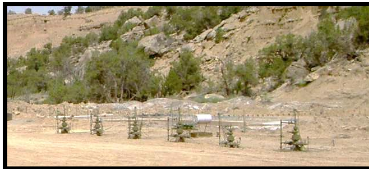
Figura 3.6: Diagrama de 6 pozos perforados desde una sola plataforma multi pozo (EXCO, 2014).
