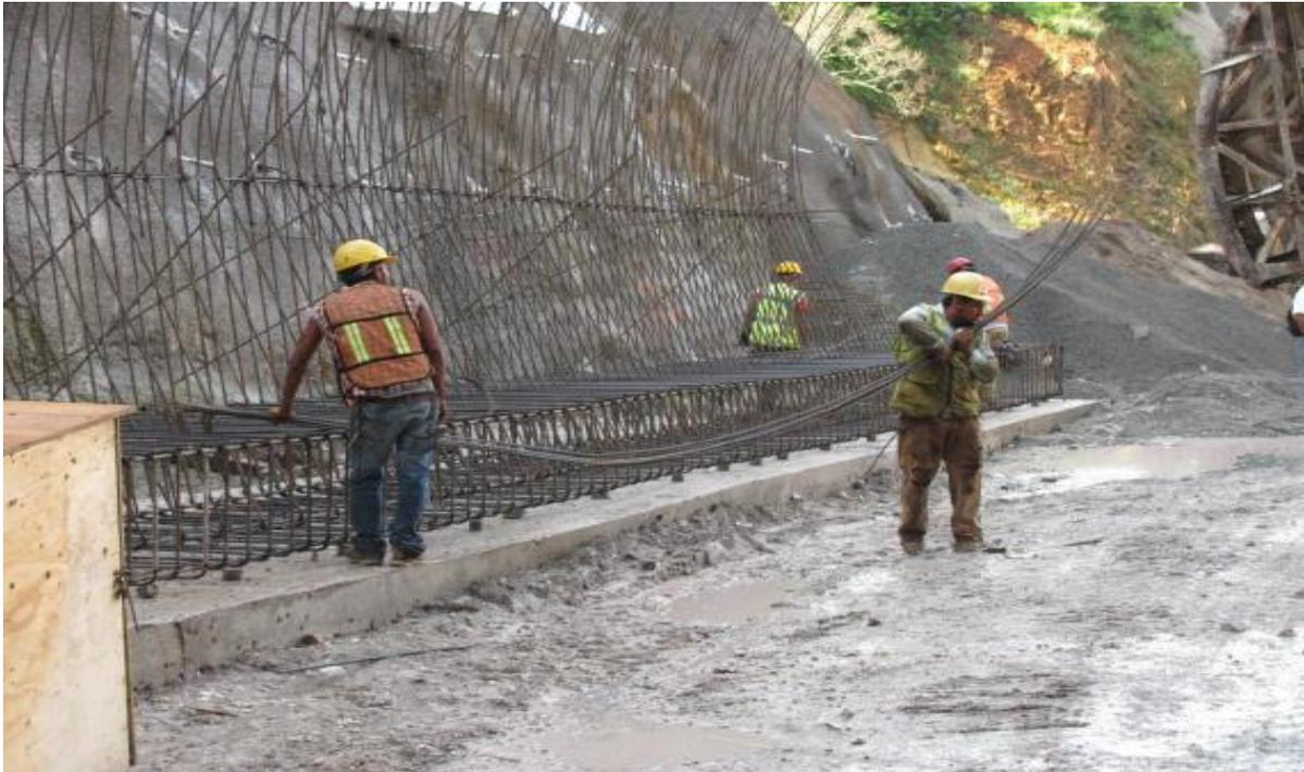
Fig. No. 162 Fabricación de Zapatas para el túnel falso
