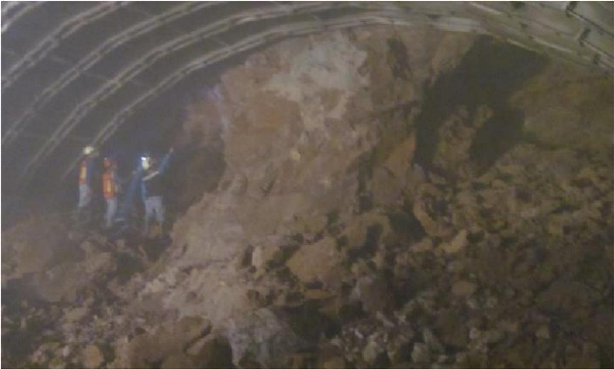
**Fig. No. 110 Avance por medio de túnel piloto**
