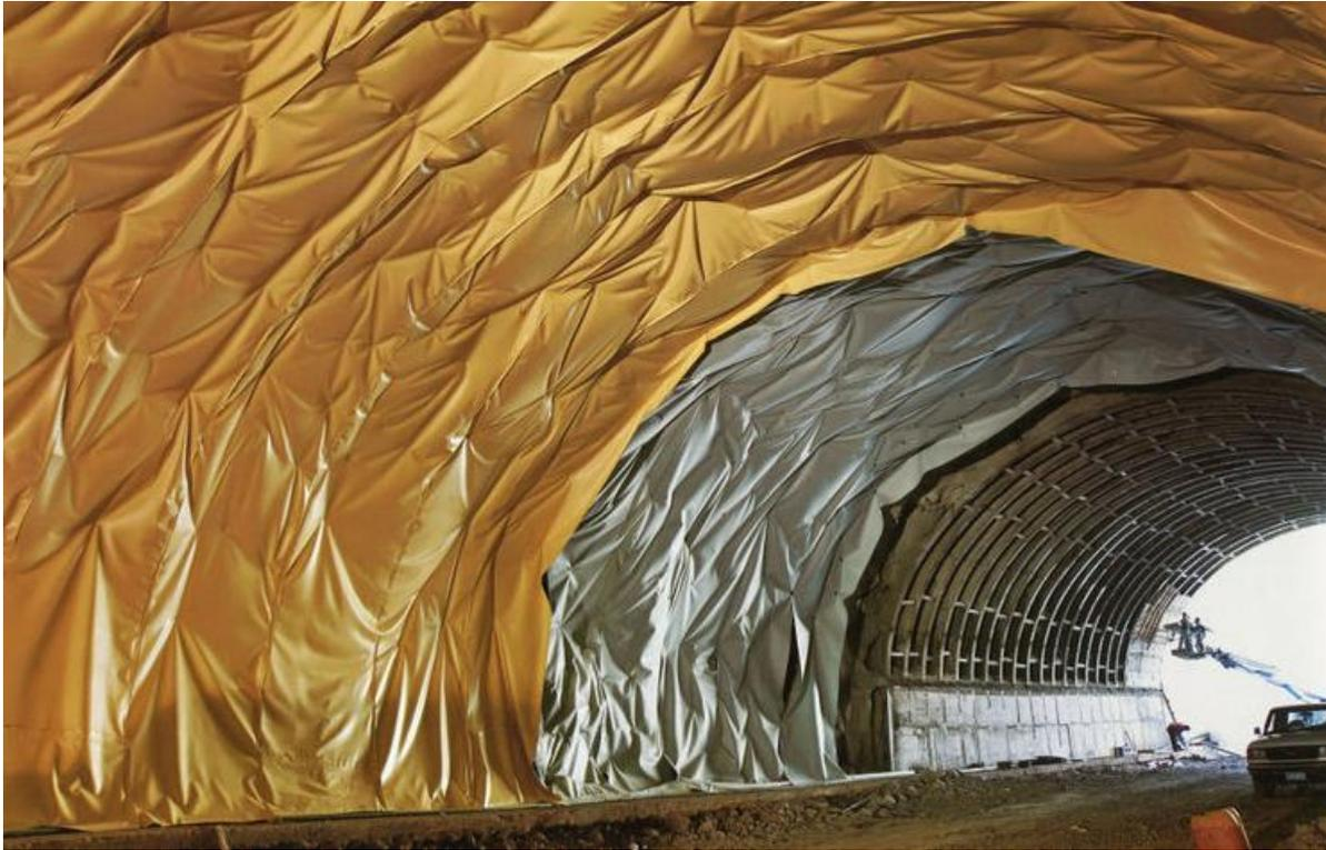
**Fig. No. 139** Instalación de geotextil
