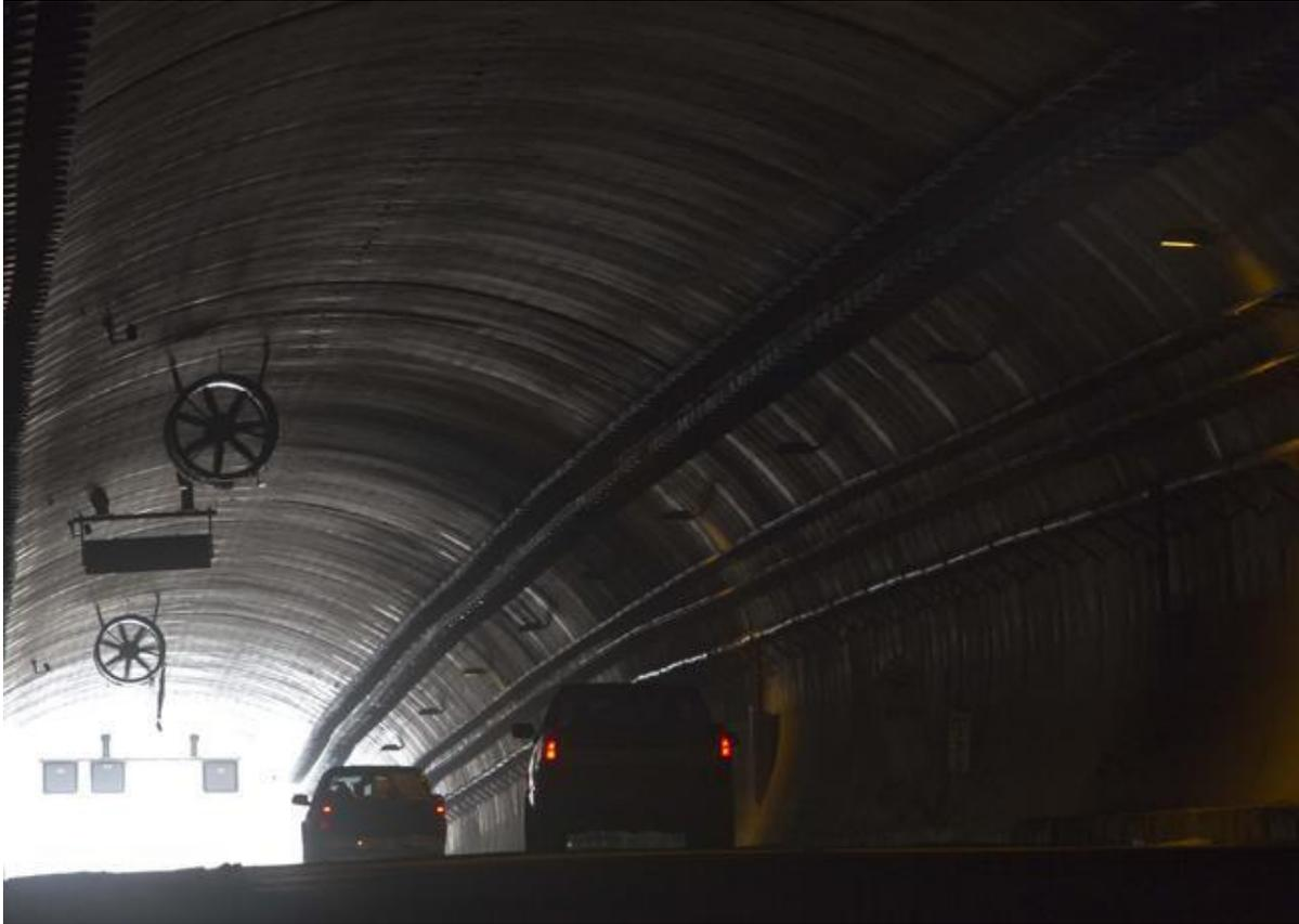
**Fig. No. 13** Equipo de ventilación del Túnel Sinaloense
