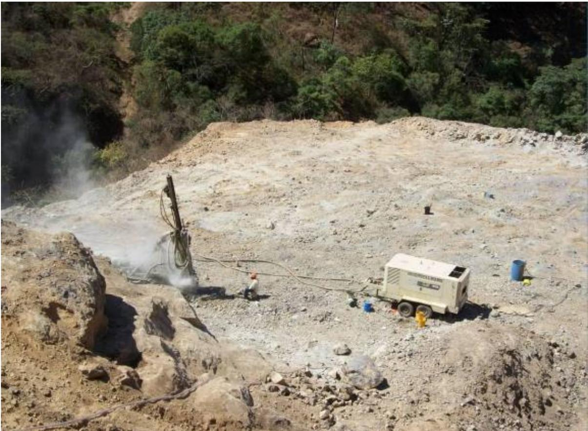
**Fig. No. 44 Equipo realizando barrenación en línea**
