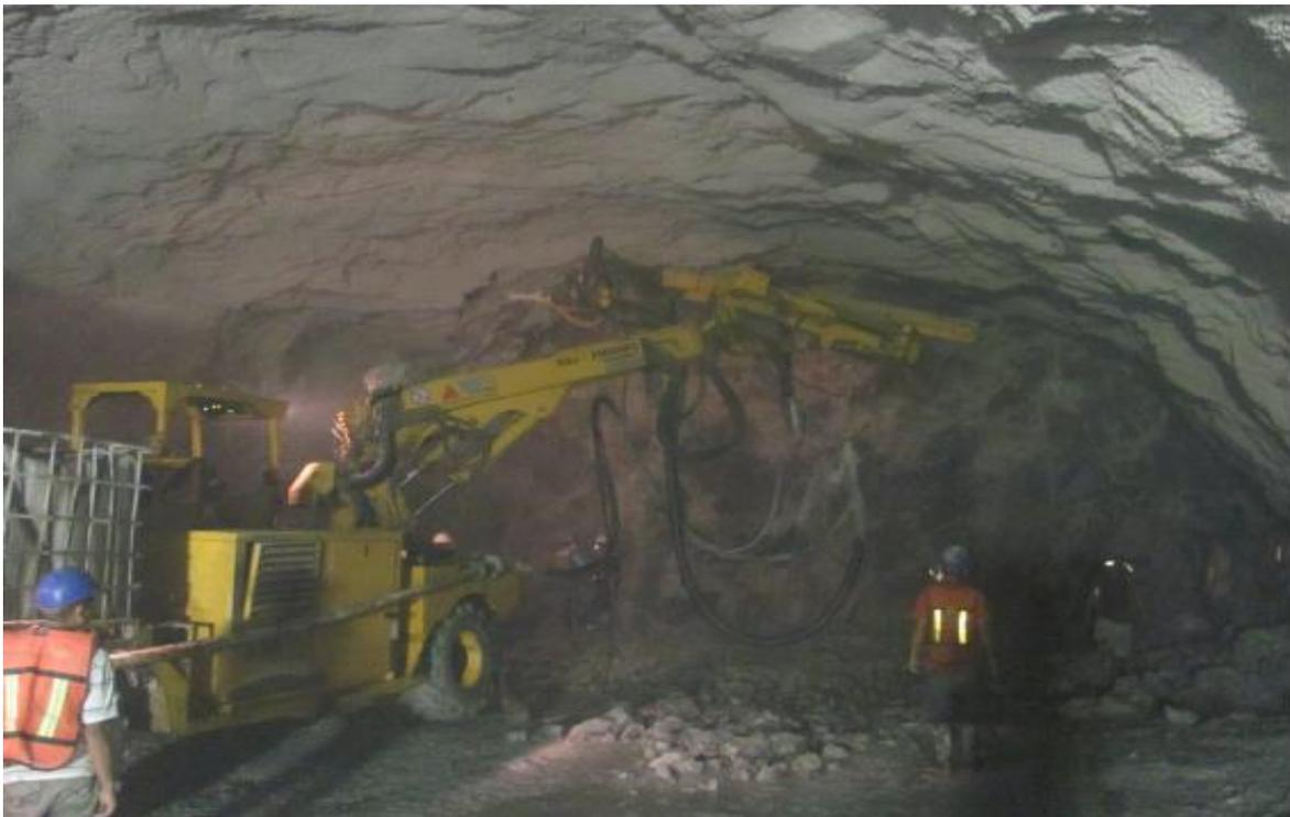
**Fig. No. 111 Recubrimiento del avance a base de concreto lanzado**
