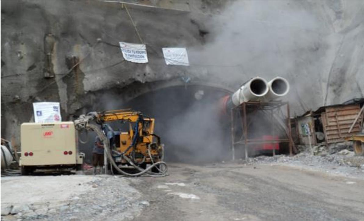
Fig. No. 101 Equipo de ventilación en el Túnel
