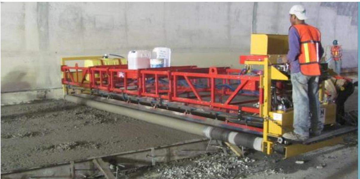
Fig. No.146 Colocación de concreto en pavimentos
