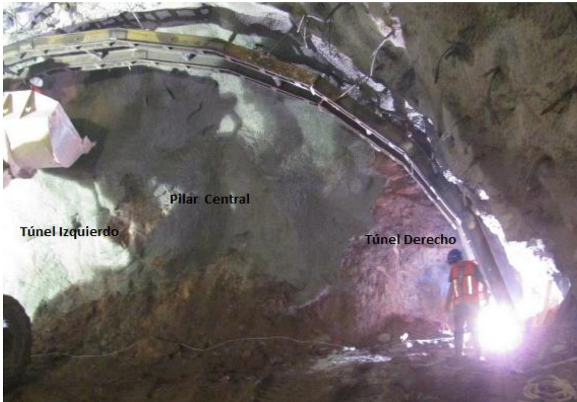
Fig. No. 120 Colocación del sostenimiento definitivo
