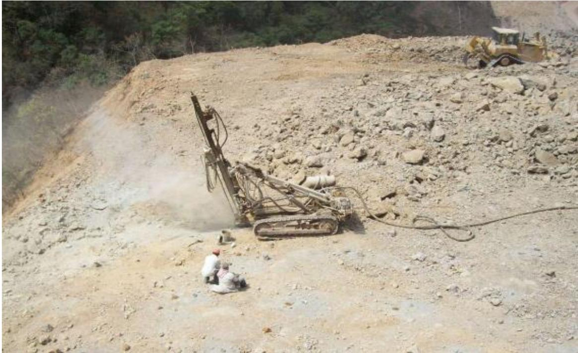
(Fig. No. 45) Equipo de barrenación y rezaga.
