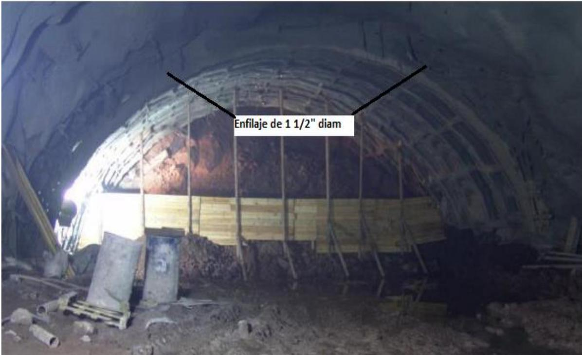
Fig. No. 134 Colocación de enfilajes
