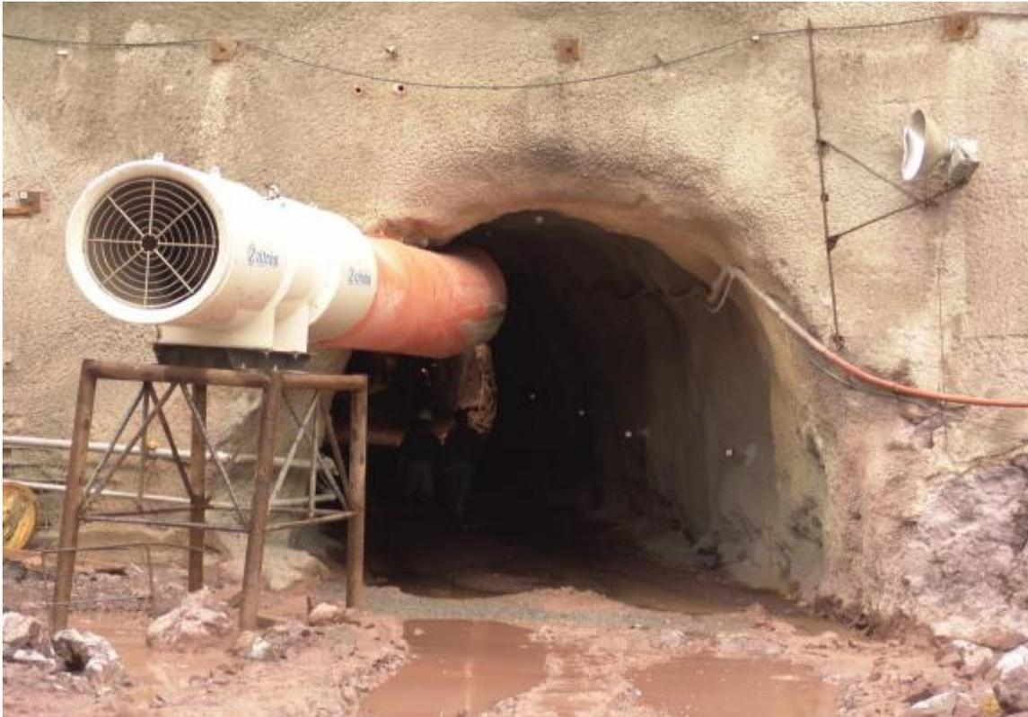
**Fig. No. 103** Equipo de ventilación en la Galería
