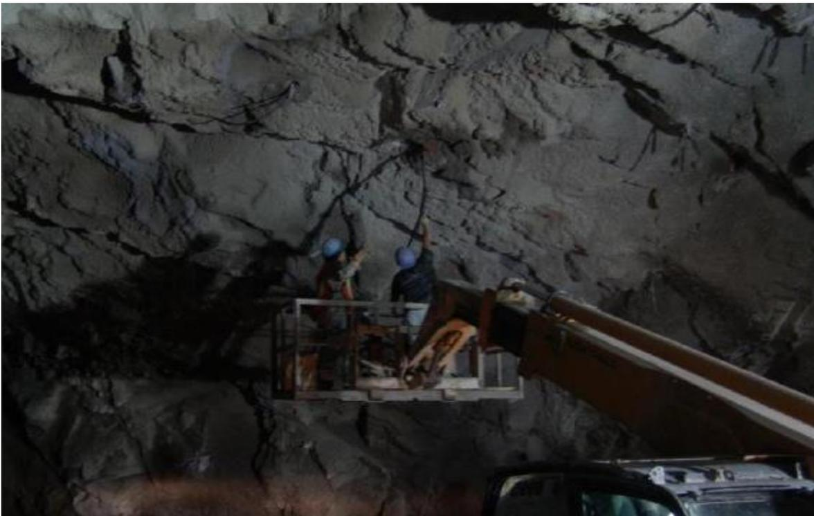
**Fig. No. 114 Colocación de anclas de fricción**
