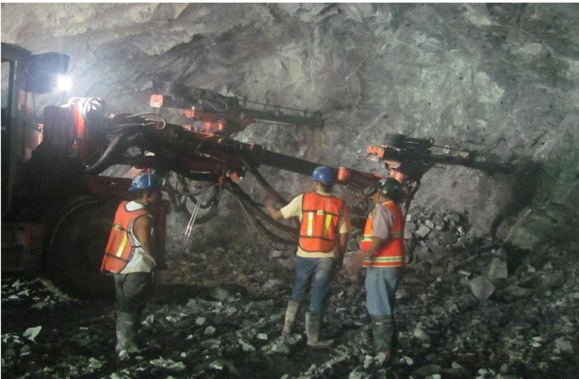
**Fig. No. 94 Barrenación en Sección Bóveda**
