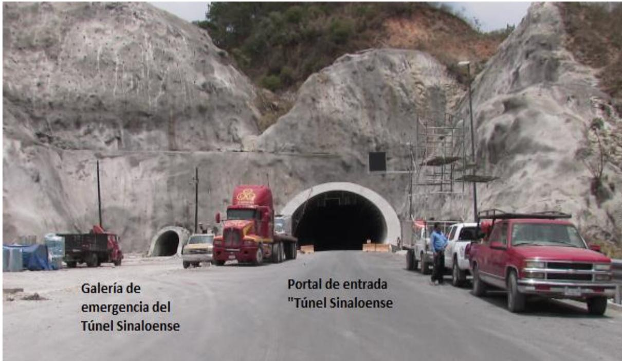
**Fig. No. 14 Ubicación del Túnel Sinaloense y Galería de Emergencia**
