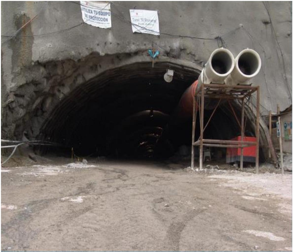
**Fig. No. 100** Equipo de ventilación en el Túnel
