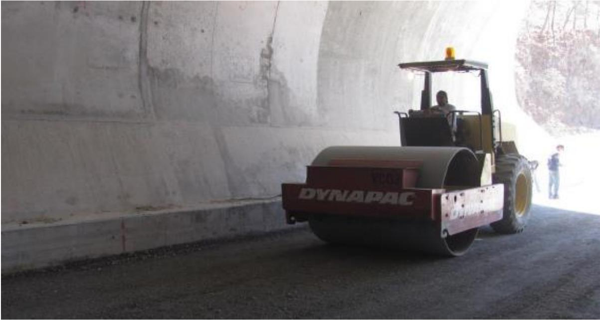
Fig. No. 145 Colocación de la base hidráulica
