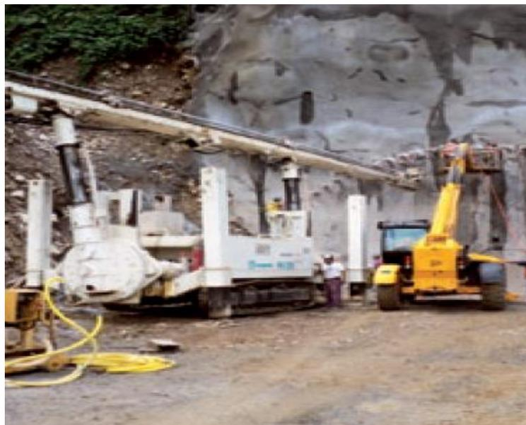
Fig. No. 62 Equipo realizando inyección de lechada
