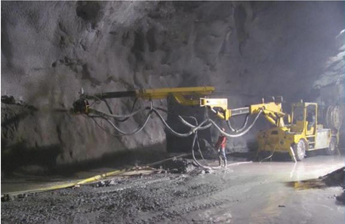
**Fig. No. 136** Equipo de lanzado de concreto
