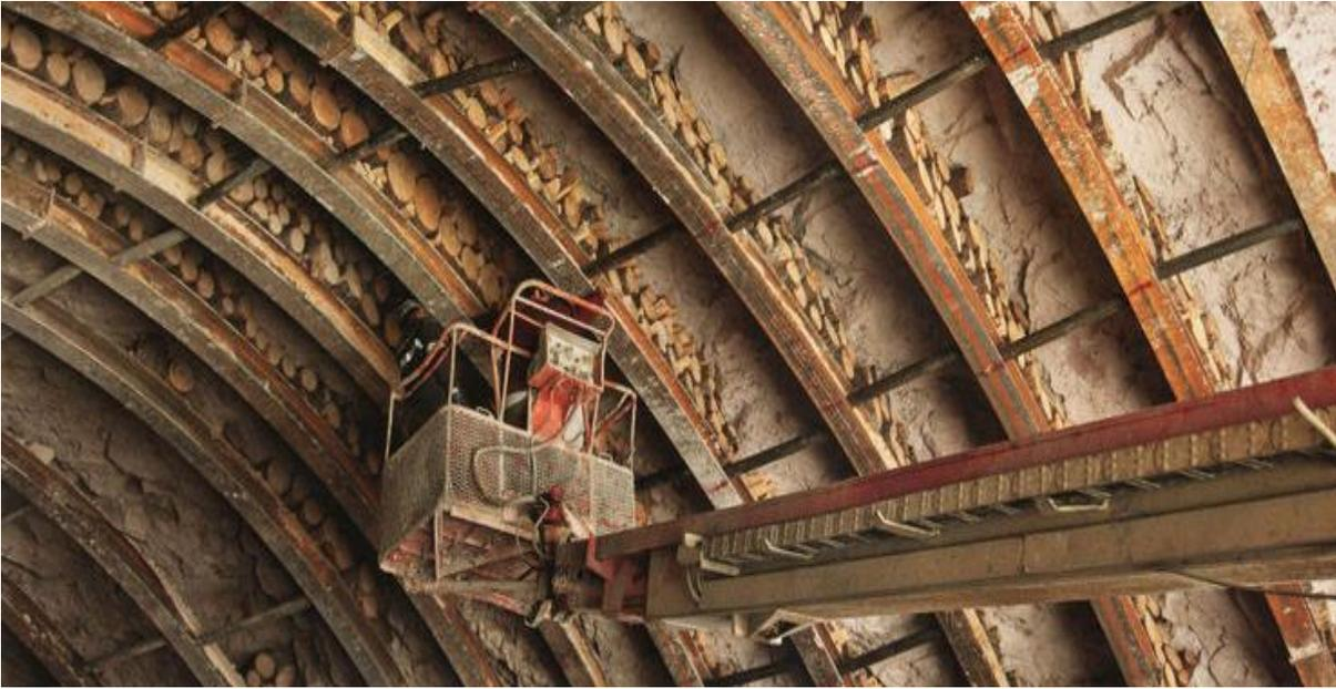
Fig. no. 117 Retaque de madera entre el marco metálico y recubrimiento de concreto.
