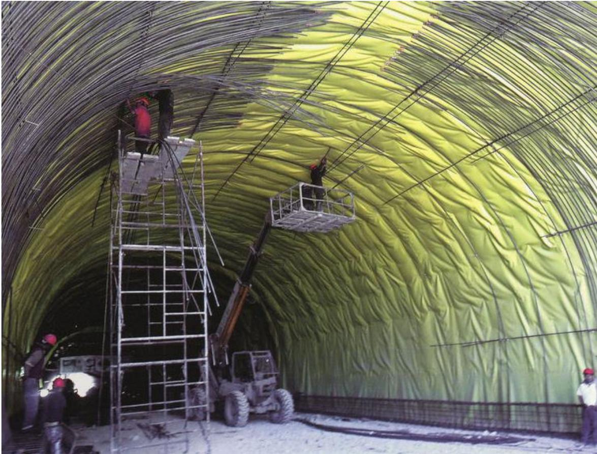
Fig. No. 140 Instalación de Geomembrana
