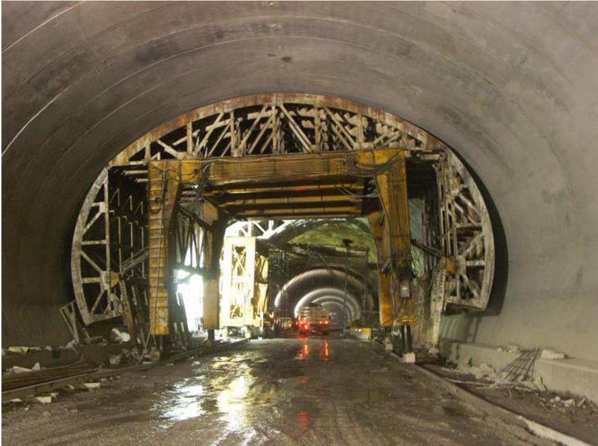
Fig. No. 143 Acabado de recubrimiento final
