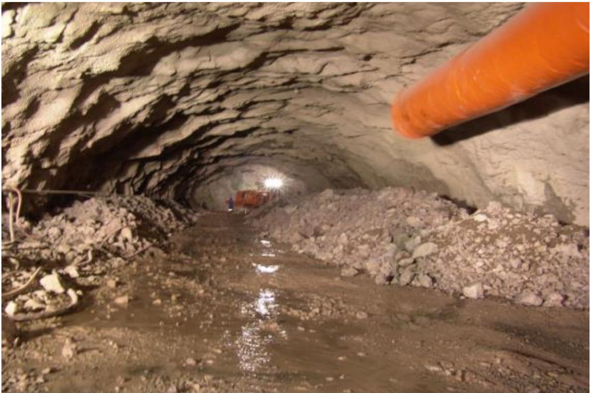
(Fig. No. 102) Tubería de ventilación en el frente de excavación
