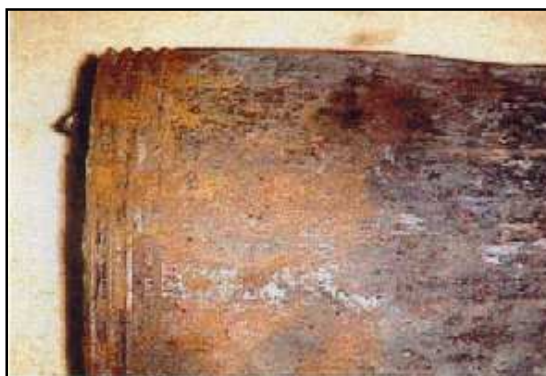
Figura 3.1.1 Efectos de corrosión y desprendimiento en una conexión API
