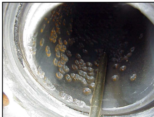
Figura 3.1.2a Efectos de corrosión por CO 2 conocida como "pitting".
