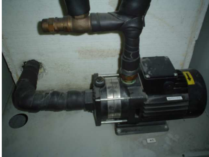
Figura 2.13 Tanque de refrigeración y bomba de agua encontradas en el módulo externo de la máquina CNC.
