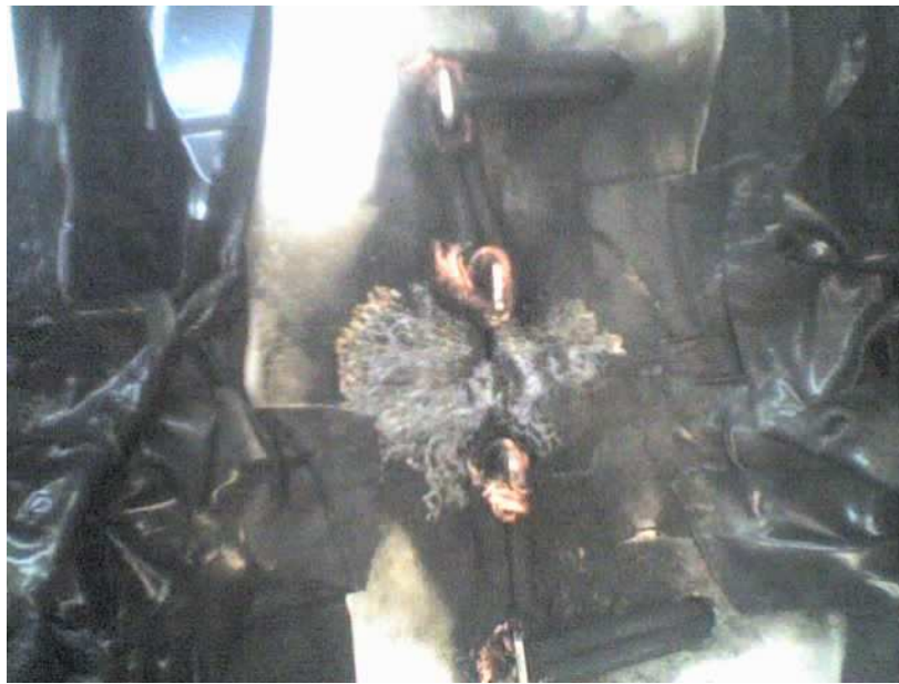
Figura 2.17 Tarjeta de estireno quemada debido a un arco eléctrico.
