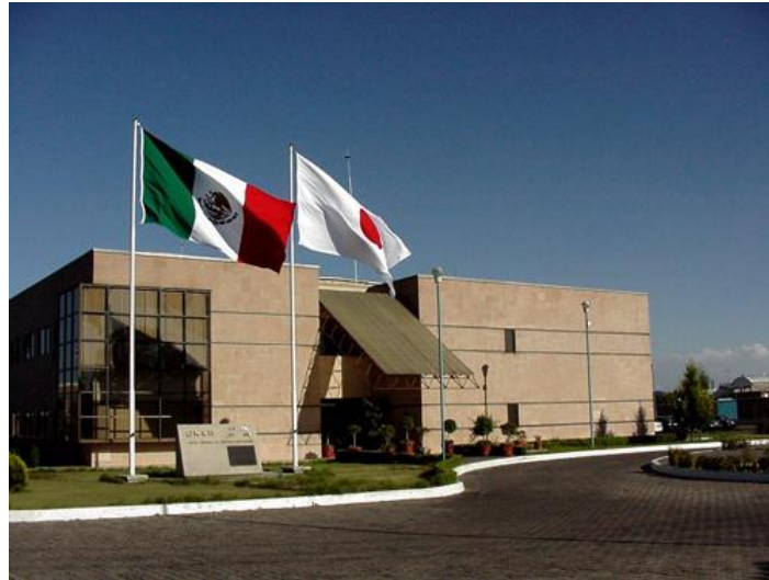
Figura 3. Instalaciones del CNAD
