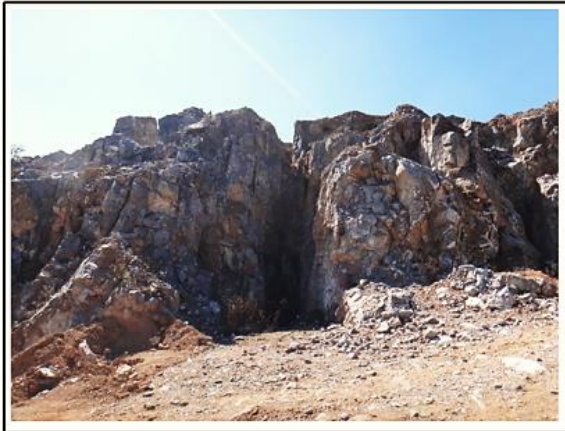
Figura VI-2. “Guato” de 2 m de ancho y 1 m de altura, la dirección de las fracturas es S45°W, casi verticales y paralelas, formando las paredes de los “guatos”.
