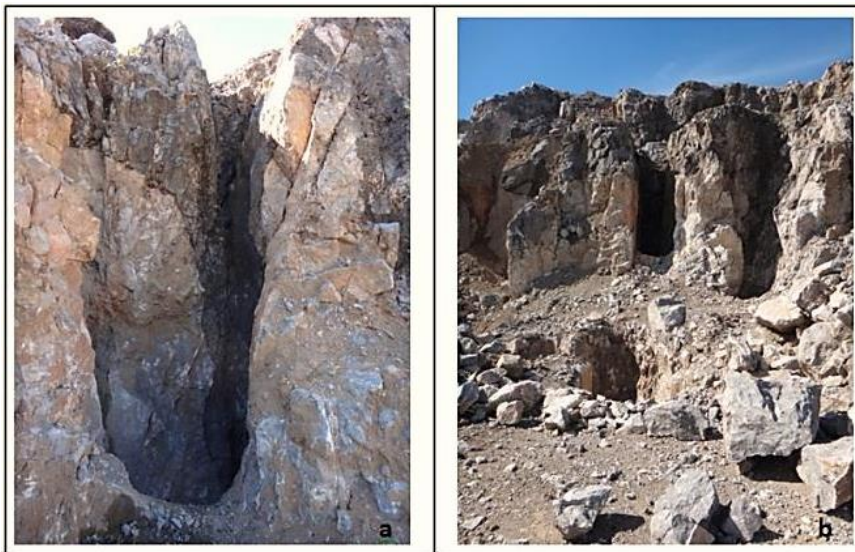
Figura III-13. La fotografía a muestra un “guato” vacío, las fracturas al N75°E con un m de ancho 5 de altura y 7 hacia adentro. La figura b muestra gustos expuestos, las fracturas forman parte de las paredes de los “guatos”. Ambos se encuentran en el área 2.
