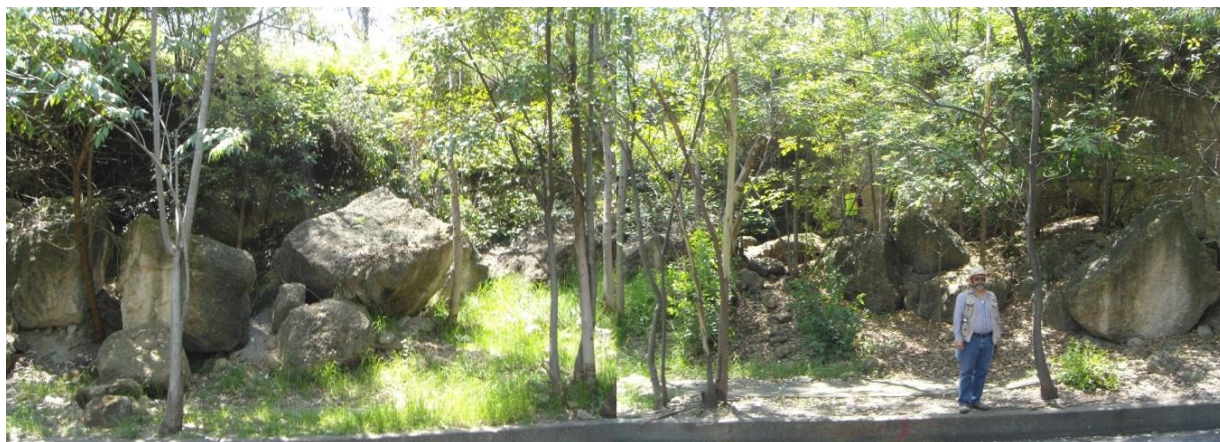
Fig. 21. Aquí, el talud debería ser continuo con una altura de 5 a 6 metros.
