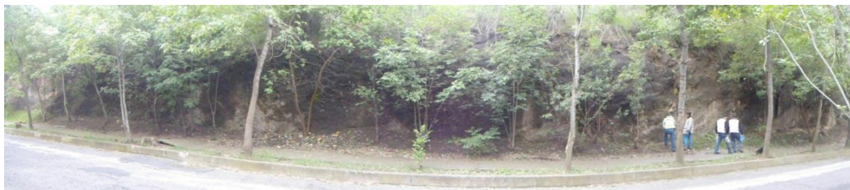
Fig. 25. Imagen panorámica de la segunda mitad del talud. La cima conserva al mismo nivel, lo que acorta su altura es la pendiente del trazo de la calle.
