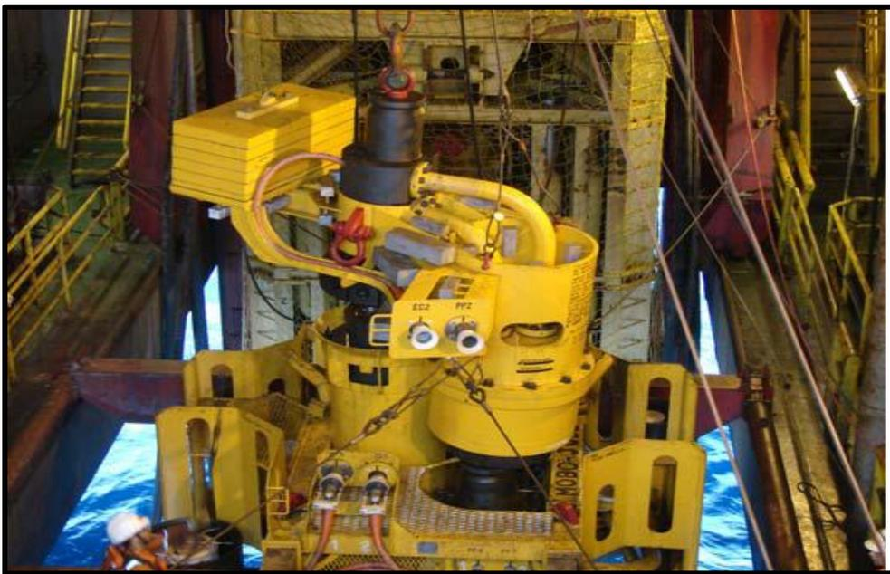
Figura 4.36 Instalación del módulo de bombeo
