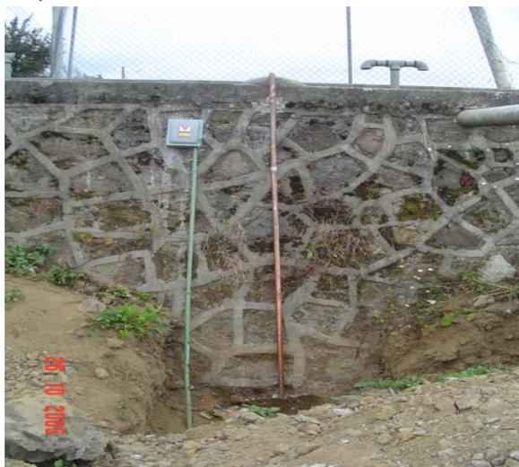
Caja de fusibles y tubería de PVC de la acometida eléctrica de la bomba, tubería de cobre de 1" de descarga de la bomba al tanque de distribución.
