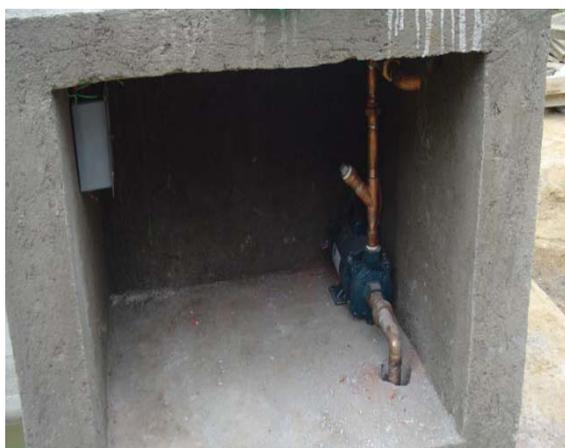
Caseta de protección de la bomba de 0.75 hp check y centro de carga con pastilla de 15 amp.
