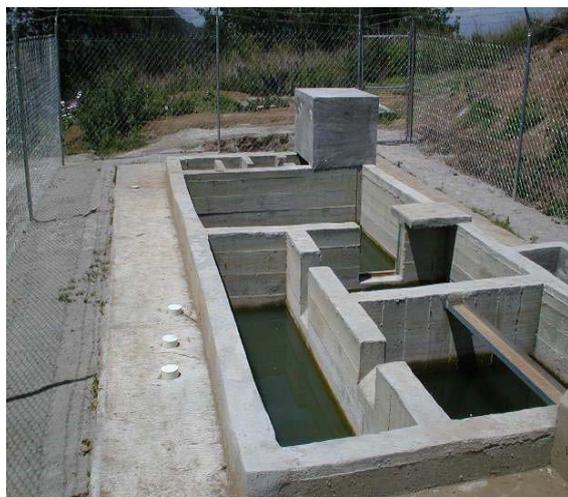
Filtros 1, 2, 3, tanque de recuperación de agua de lavado y caja de válvulas D1, vertederos y compuerta.
