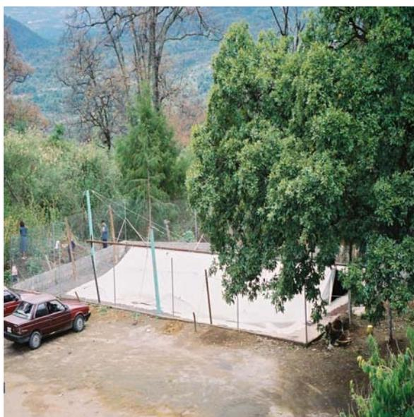
Olla de almacenamiento de 228 m<sup>3</sup>, en donde se deposita el agua antes del bombearse al hidrante.
