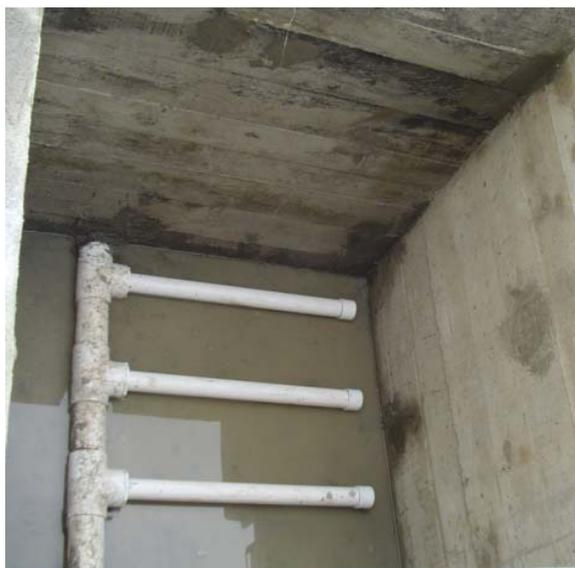
Ramal de PVC hidráulico RD-26 del filtro F2.
