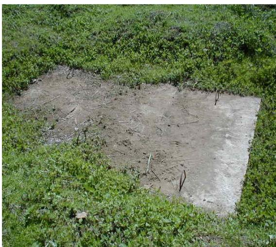
Sedimentador con tapa de concreto para evitar contaminar el agua.
