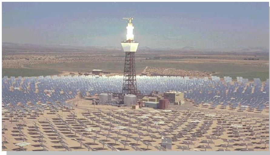
Figura No. 3.5 Proyecto Solar Tres de 17MW. Fuente: Prospectiva de las Tecnologías Termosolares a Concentración para la Generación de Potencia Eléctrica, Ing. Carlos Ramos Berumen, México 2005.
