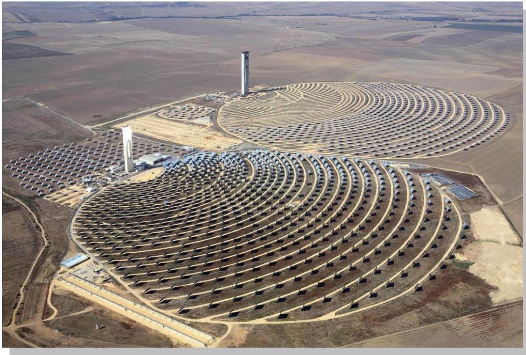
Figura No. 3.6 PS10 y PS20 de 11MW Y 20MW respectivamente. Fuente: Abengoa Solar , http://www.abengoasolar.es
