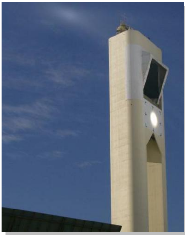
Figura No. 3.13 El receptor de la PS10 es de tipo de cavidad. Fuente: Abengoa Solar , http://www.abengoasolar.com/ , 2009.
