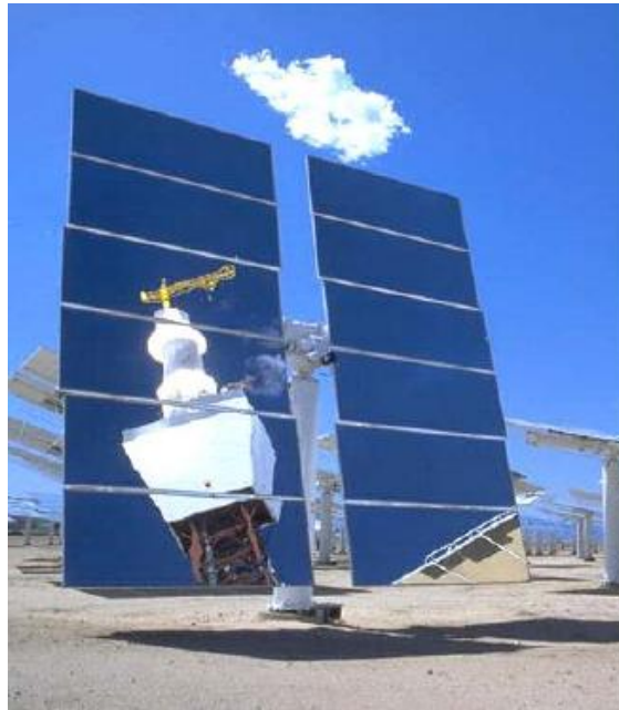
Figura No. 3.14 El receptor de la planta Solar Tres es de tipo de recepción exterior. Fuente: Energía Solar: Estado actual y perspectiva inmediata, SENER, 2005.
