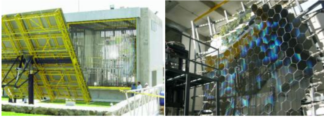
Figuras 11 y 12. Imagen del exterior del horno solar y heliostato (izquierda). Imagen del concentrador del horno solar (derecha). [1.4]
