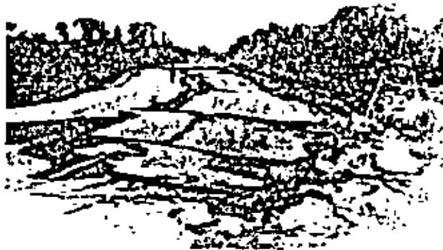
Problemas de licuación del terreno de cimentación bajo terraplenes bajo un sismo (Jáltipan, 1957).
