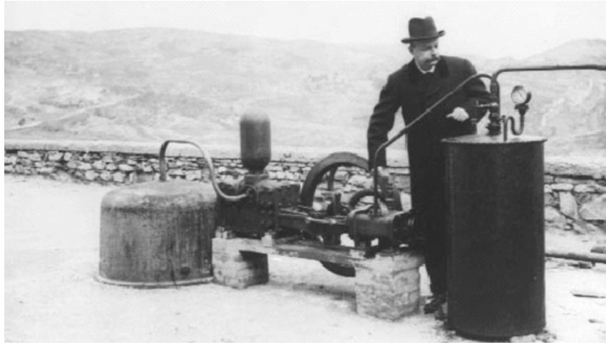
Figura 3.2 Instalación de generación de energía eléctrica de origen geotérmico en Larderello (Italia), en 1904. Fuente: Geothermal Education Office 2000.
