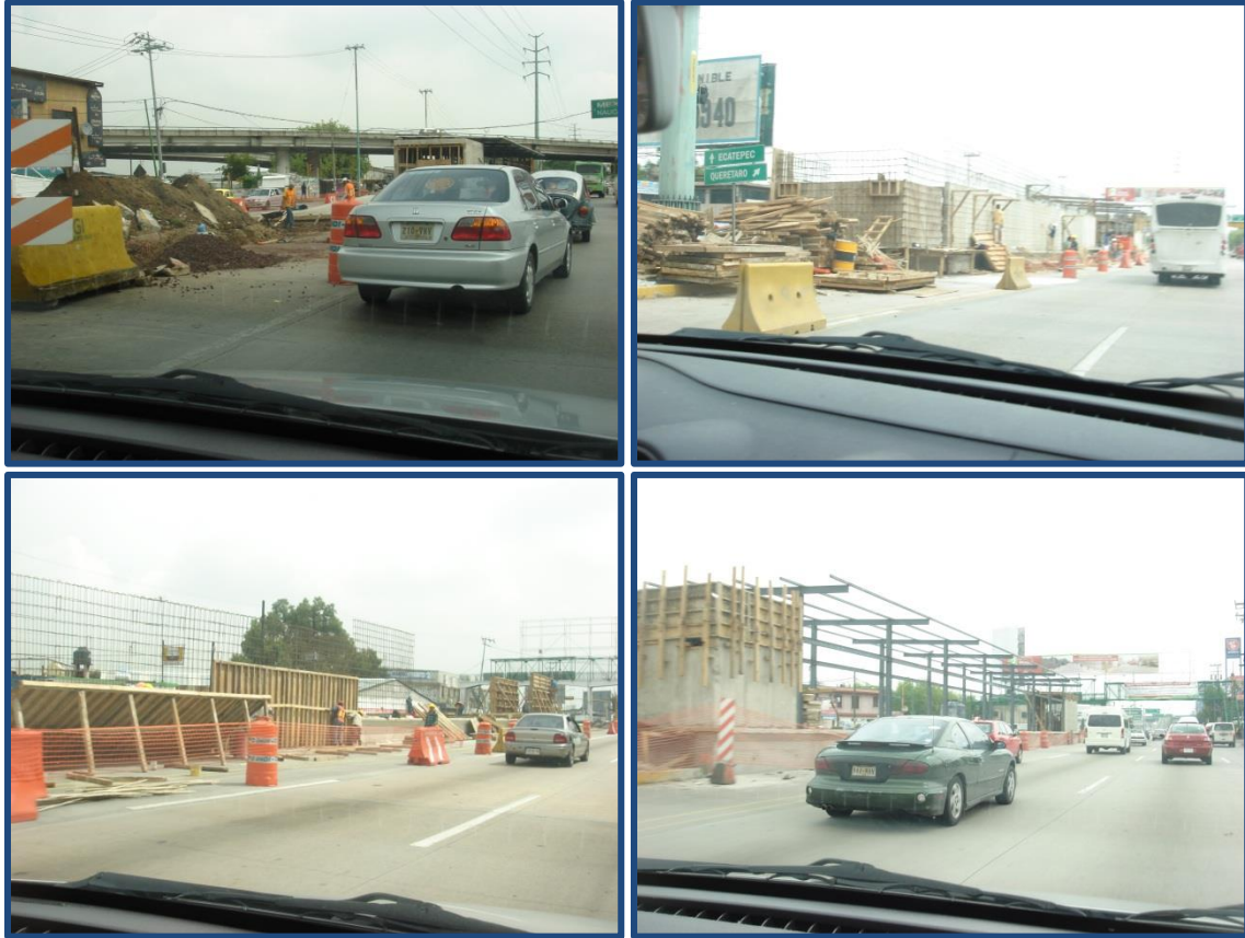
Figura 3.12 Construcción de las estaciones de Mexibús
