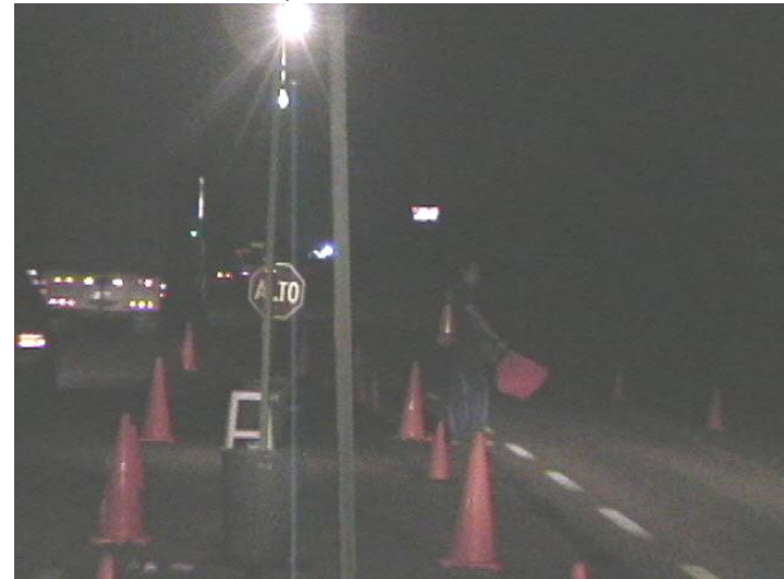
Estación OD Aeropuerto iluminación turno nocturno 03
