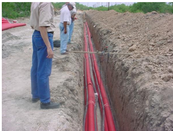
Foto 15. Montaje de ductos antes de ser rellenados con concreto
