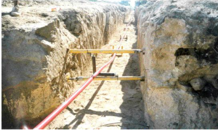
Foto 12. Forma de tendido del cable de energía
