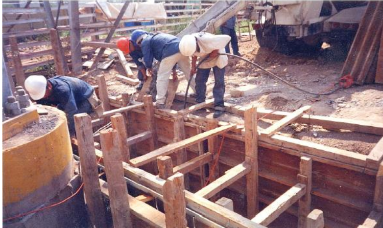
Foto 11. Troquelado para la protección del personal de instalación Fuente: Instalación, montaje, conexiones y pruebas de cables de energía de alta tensión
