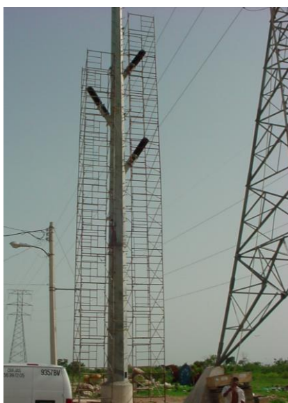
Foto 26. Instalación de cable en poste
