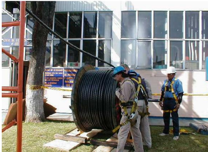
Foto 28. Montaje del carrete en el desenrollador Fuente: Condumex. Manual técnico de cables de energía
