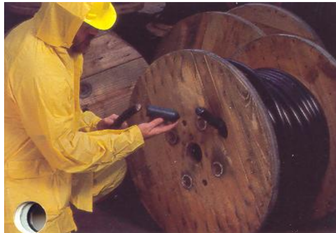
Foto 1. Verificación del sello de capuchones termocontráctiles
