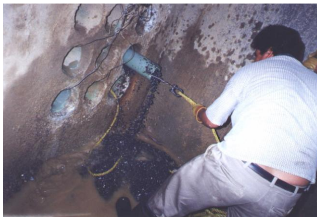
Foto 17. Limpieza de los ductos
