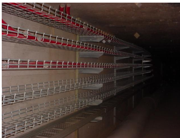
Foto 27. Montaje de cable en charolas
