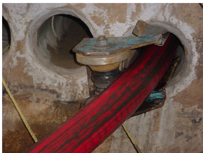
Foto 9. Uso de rodillo para la instalación de cable en ducto
