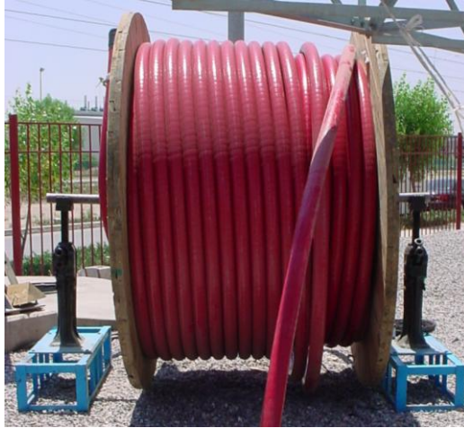
Foto 5. Durante el tendido
