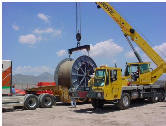
Foto 3. Manejo correcto de los carretes con grúa
