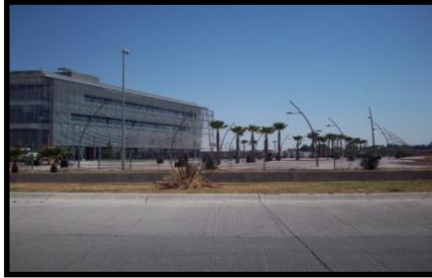
Figura 3.89 Avance de Obras y Ocupación Puerto Interior Silao – León
