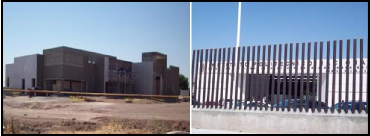
Figura3.93 Avance de Obras y Ocupación Puerto Interior Silao – León
