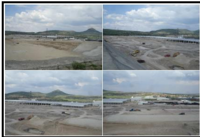
Figura 3.72 Centro de Distribución COSTCO. ab
