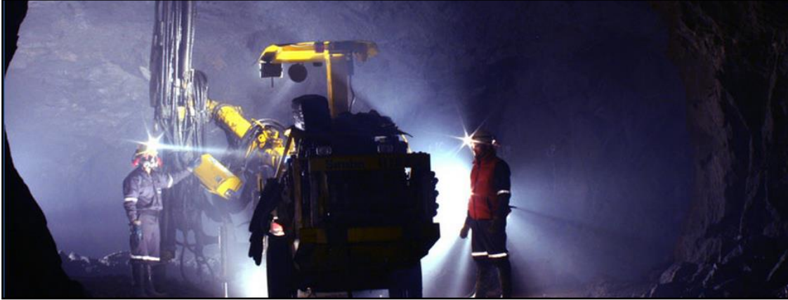
Imagen3: Ingenieros supervisando una perforación al interior de la mina subterránea
