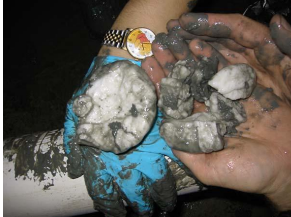
Figura 37.- Estructura en forma de tapón de hidrato de un ducto que transporta gas natural
