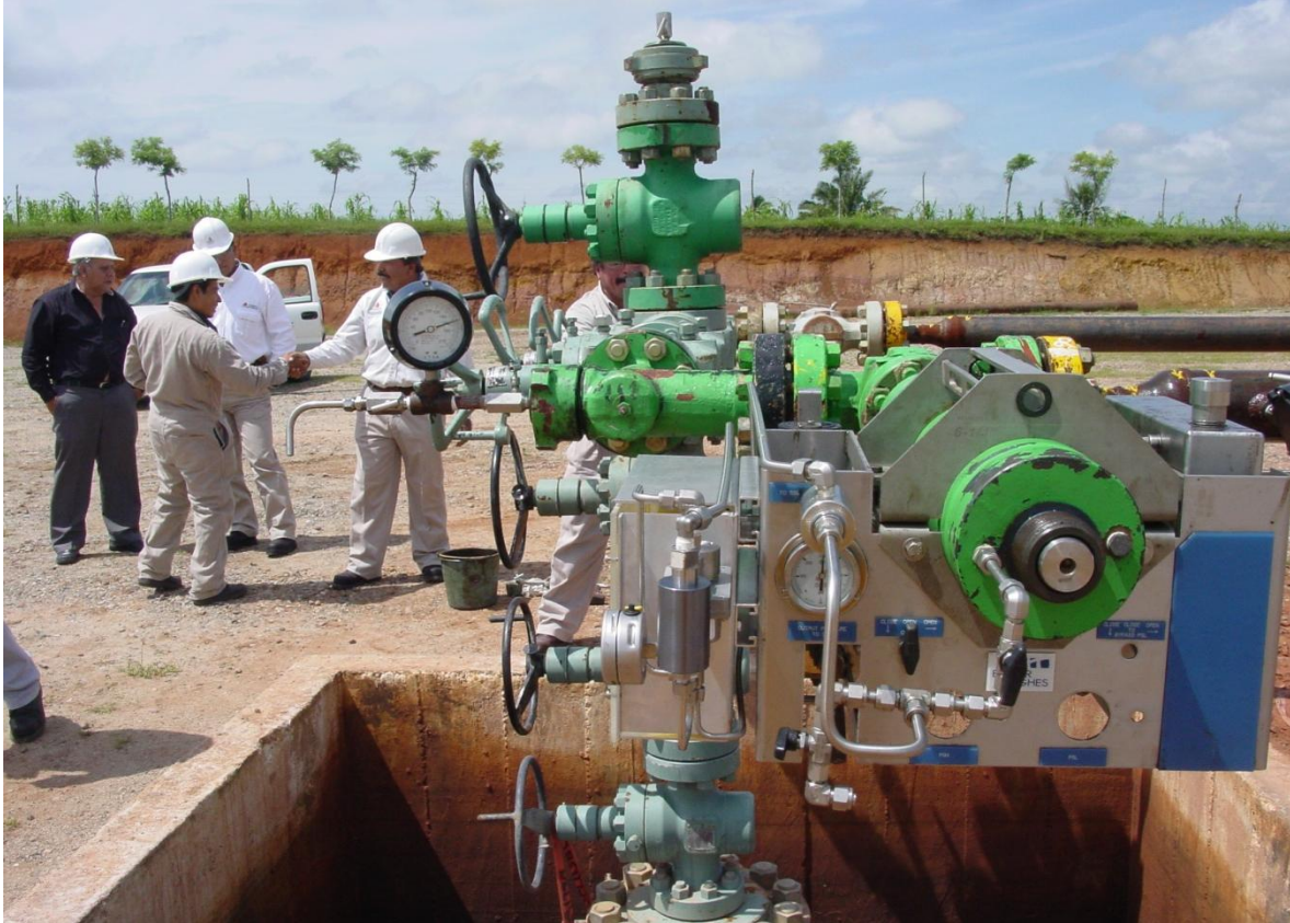
Fig. 233.- Prueba Tecnológica de Válvulas laterales de uso severo en el pozo Mundo Nuevo 201.
