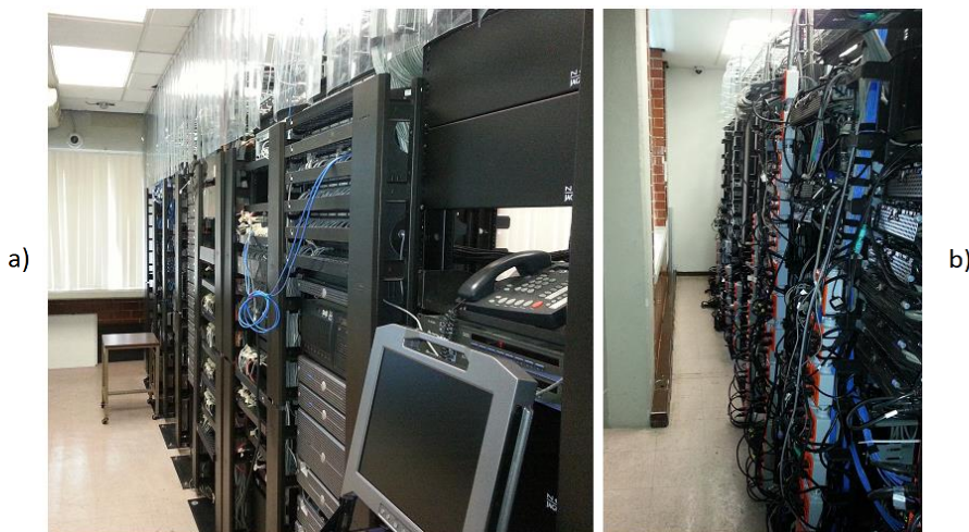
Figura 76 a) Fotografía del pasillo 1 b) Fotografía del pasillo 2.
