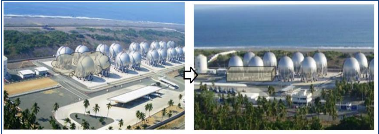
Figura 5.12: Imagen que ejemplifica la nube originada por la fuga de propano (Imagen obtenida de Internet 23 ).
