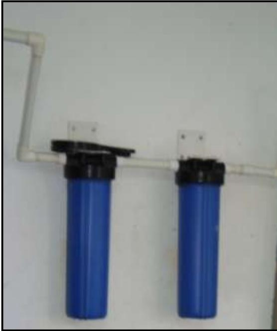
**Fig. 12 Microfiltración.**
