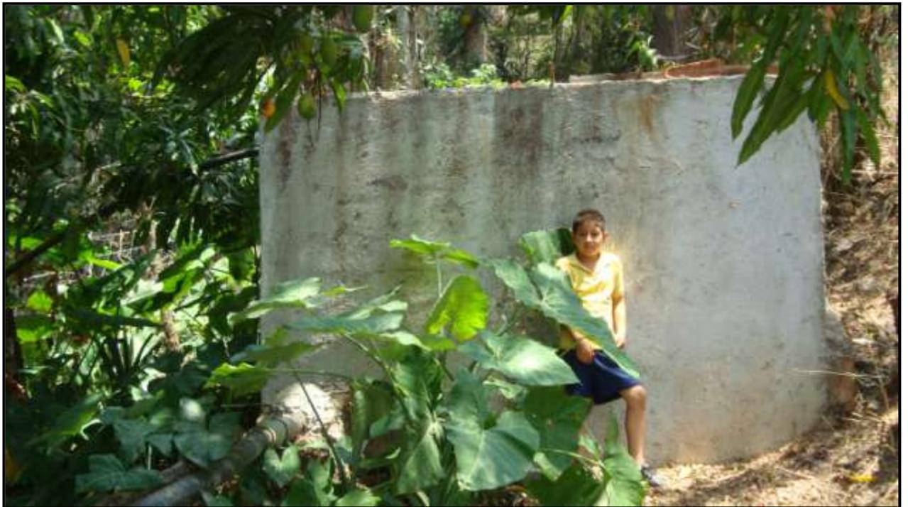
**Fig. 6 Depósito en donde se sedimentan partículas orgánicas**
