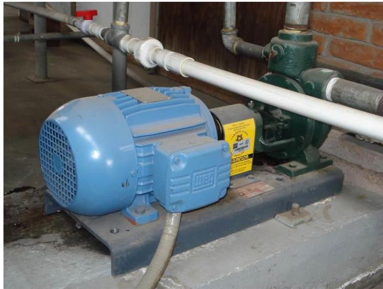
*Figura 2.6 Fotografía de la bomba utilizada para la recirculación*
