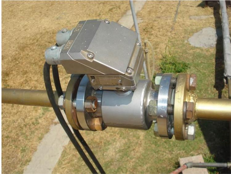
*Figura 2.8. Fotografía del Medidor de flujo a la entrada del medio de prueba.*
