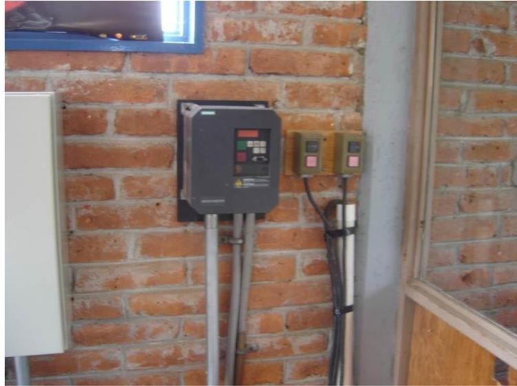
Figura 2.7 Regulador de la frecuencia del giro en la bomba, ubicado en la Planta Solar del Instituto de Ingeniería, UNAM
