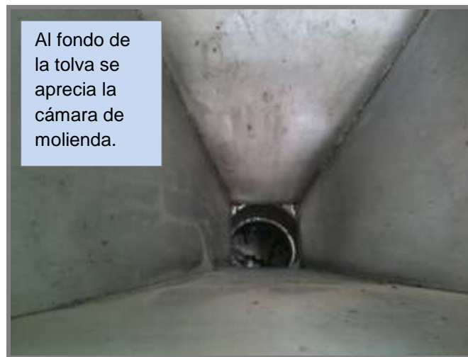
FIGURA 4.6. TOLVA DEL TRITURADOR
