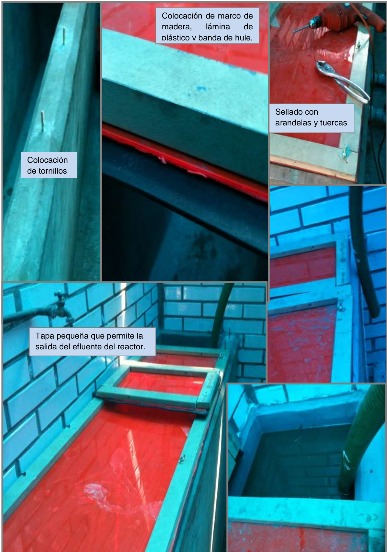
FIGURA 4.12. COLOCACIÓN DE TAPAS EN LOS ESTANQUES DE SEDIMENTACIÓN
