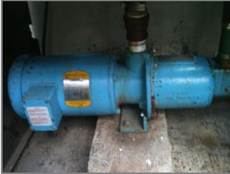
FIGURA 3.3. BOMBA MOYNO MOD.35601
