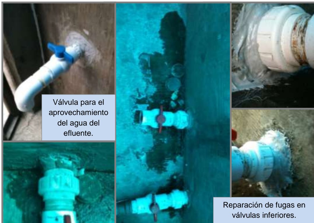
FIGURA 4.16. INSTALACIÓN Y REVISIÓN DE VÁLVULAS
