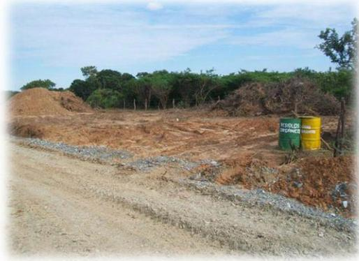
**Figura III.5.** Conformación de plataforma de montaje
