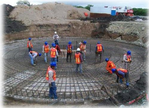
**Figura III.11.** Colocación de acero de refuerzo en cimentación de aerogenerador
