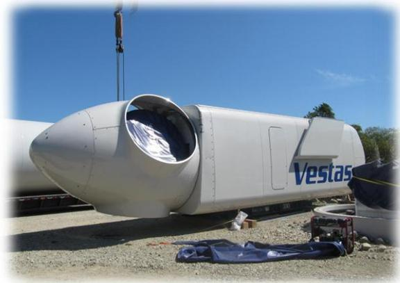
**Figura III.21.** Acoplamiento de buje en nacelle
