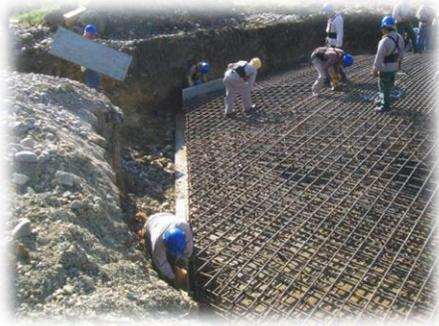
**Figura III.9.** Excavación para aerogenerador
