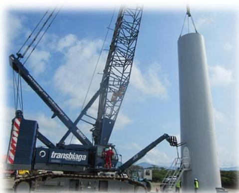
**Figura III.18.** Colocación de primera sección del aerogenerador
