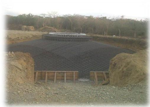
**Figura III.12.** Colocación y armado de acero de refuerzo para cimentación
