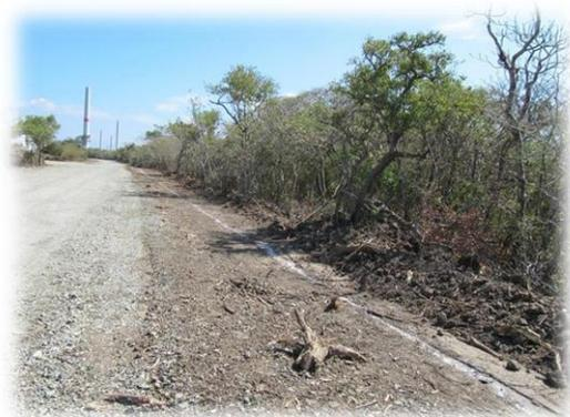
**Figura III.25.** Trazo para excavación de bus colector
