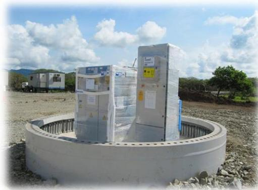
**Figura III.17.** Colocación de tablero de control
