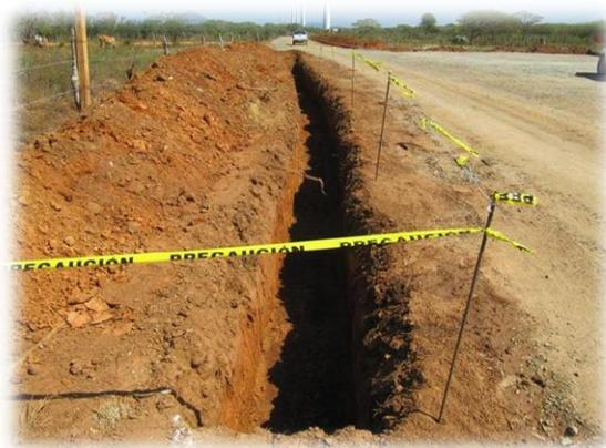
**Figura III.26.** Excavación de bus colector
