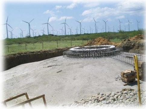
**Figura III.14.** Colocación de concreto en cimentación de aerogenerador
