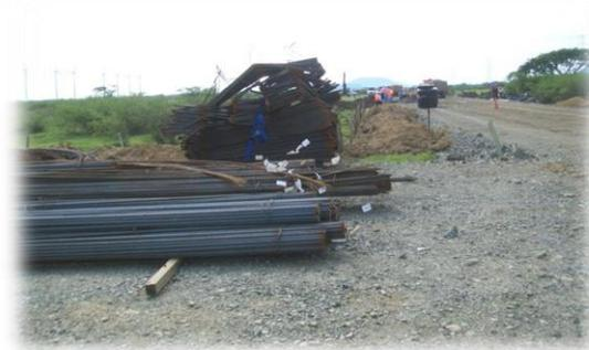
**Figura III.7** Almacenamiento de acero de refuerzo
