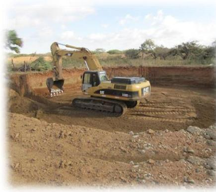
**Figura III.8.** Excavación para cimentación
