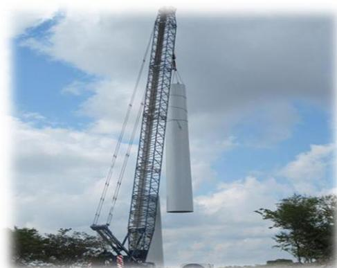
**Figura III.19.** Montaje segunda sección del aerogenerador
