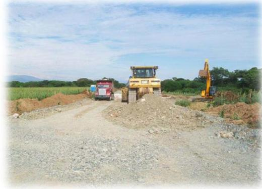
**Figura III.6.** Conformación de material de banco en camino
