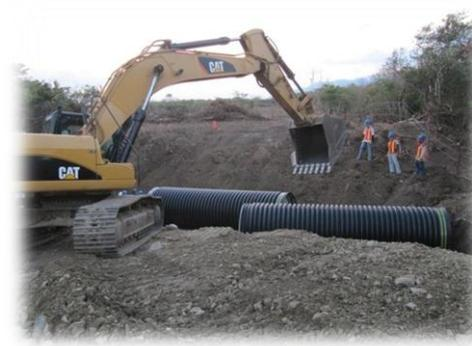
**Figura III.15.** Colocación de ductos de alta densidad
