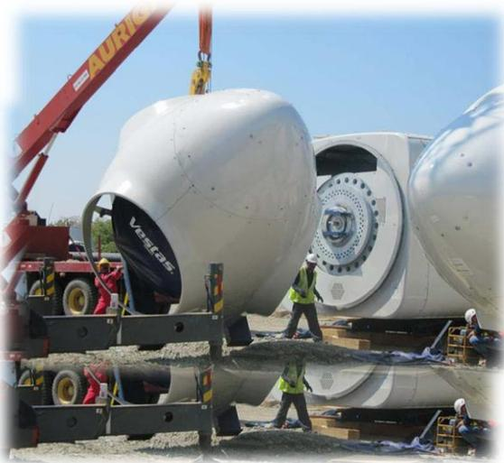
**Figura III.20.** Montaje de buje en nacelle
