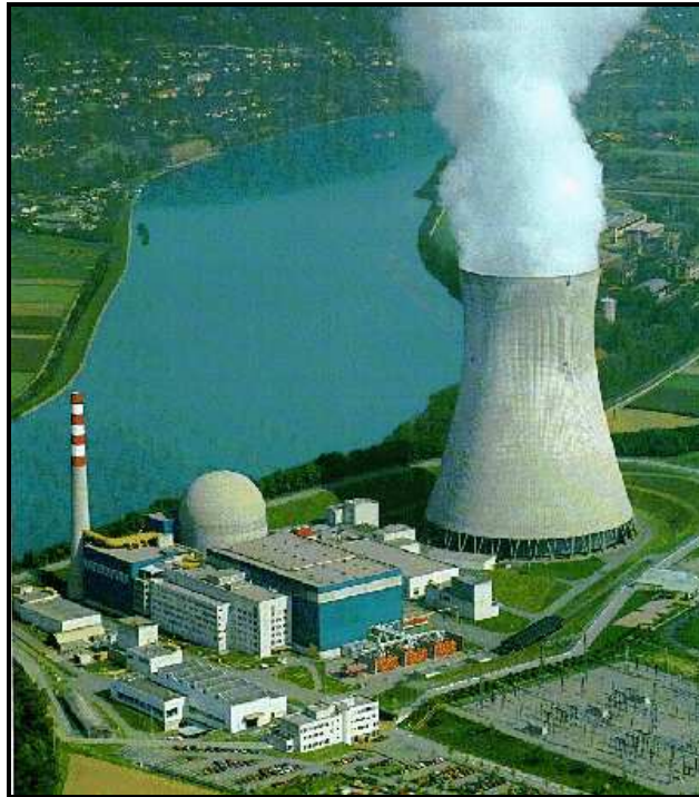
Figura 2.4 Torre de Enfriamiento
