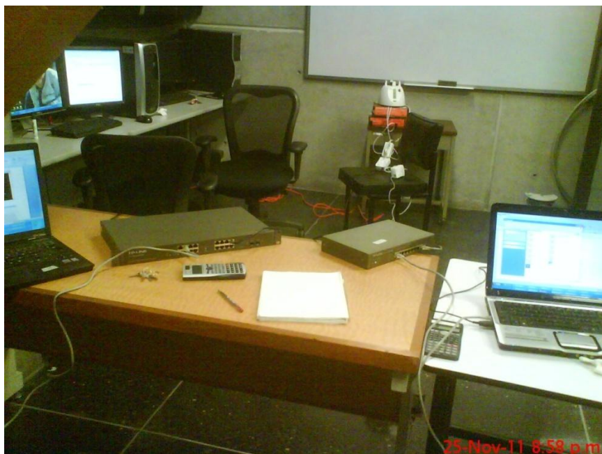
Figura 3.15 Implementación física de la topología punto a punto de la red utilizando PLC
