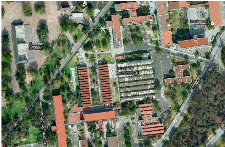
Figura 5.25 Conjunto sur de la Facultad de Ingeniería de la UNAM en Ciudad Universitaria. Figura obtenida de [24].
