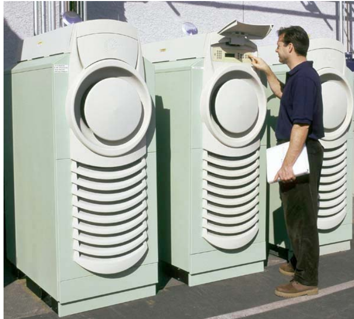
Figura 0 . Arreglo en serie de microturbinas gas
