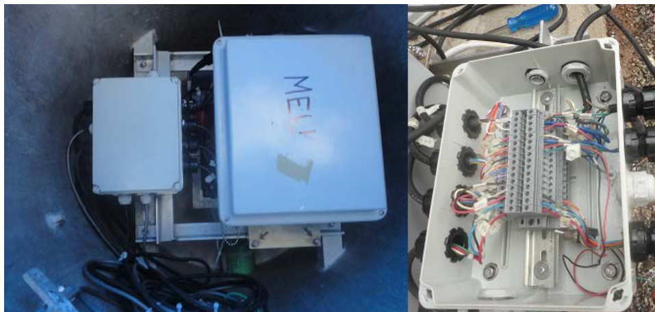
Figura 55. Montaje dentro del cilindro principal.
