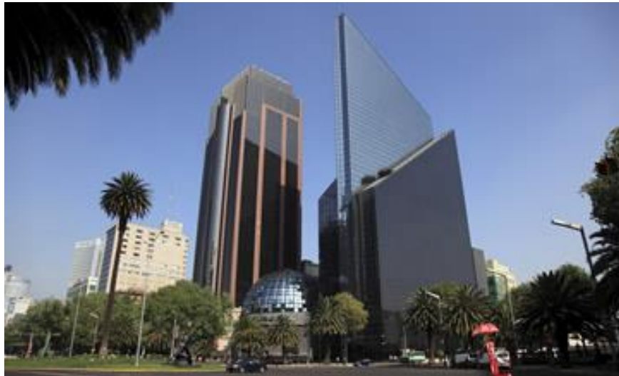
Imagen 3. Vista del edificio de la Bolsa Mexicana de Valores.
