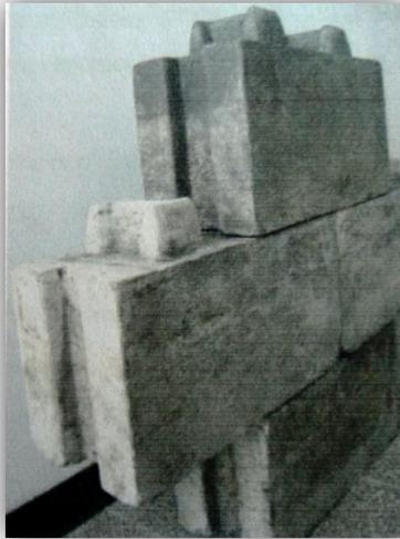
El hecho de lograr el ensamble entre las piezas, fue el resultado de lograr una exacta precisión en la elaboración del molde, pues cualquier alteración en las dimensiones impediría el ensamblaje.
