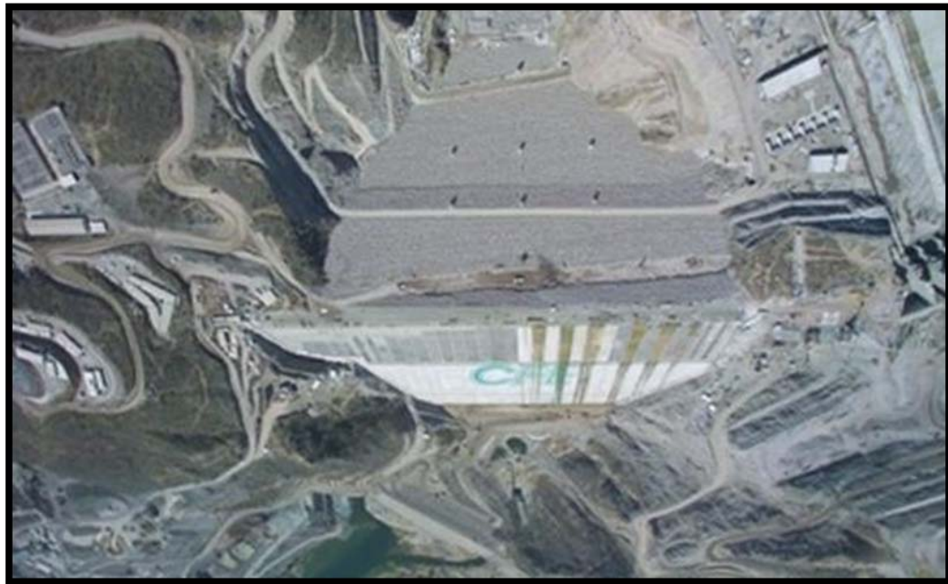
Figura 3.23. Cortina del Proyecto Hidroeléctrico El Cajón, Nayarit.
