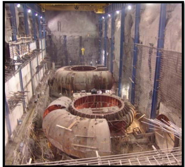
Figura 3.25. Isométrico de las obras subterráneas de generación y vista de las carcassas de casa de maquinas.
