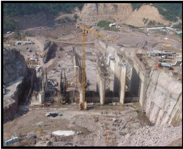
Figura 3.27. Vista desde aguas arriba de la construcción de la zona de control de la obra de excedencias.
