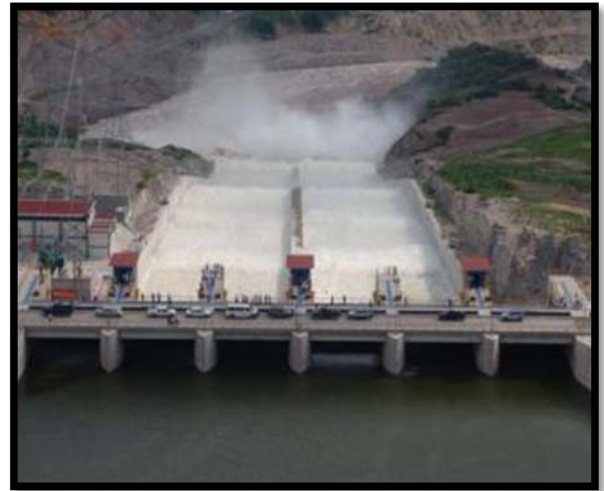
Figura 3.28. Vertedor en operación de la Central Hidroeléctrica El Cajón.
