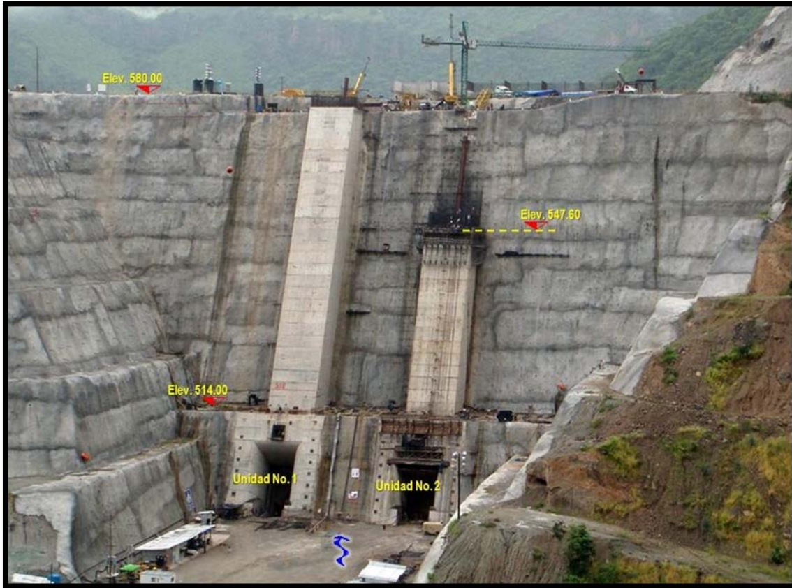
Figura 3.47. Vista de la Obra de Toma.
