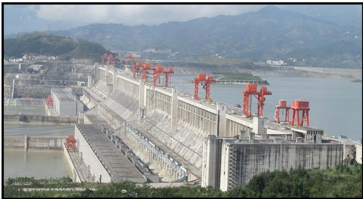
Figura 2.4. Vista de la cortina de gravedad de la Presa Tres Gargantas situada sobre el Río Yangtsé en China.
