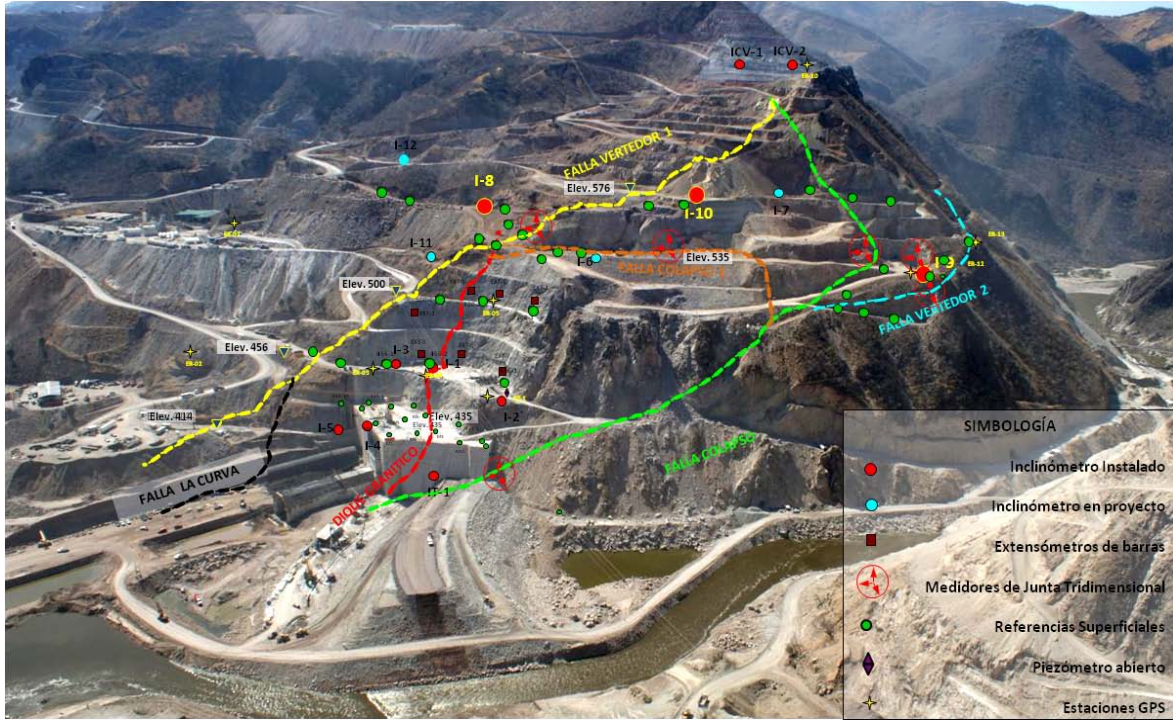
Figura 3.56. P.H. La Yesca – Instrumentación adicional en la Margen Izquierda (Marengo, 2008).
