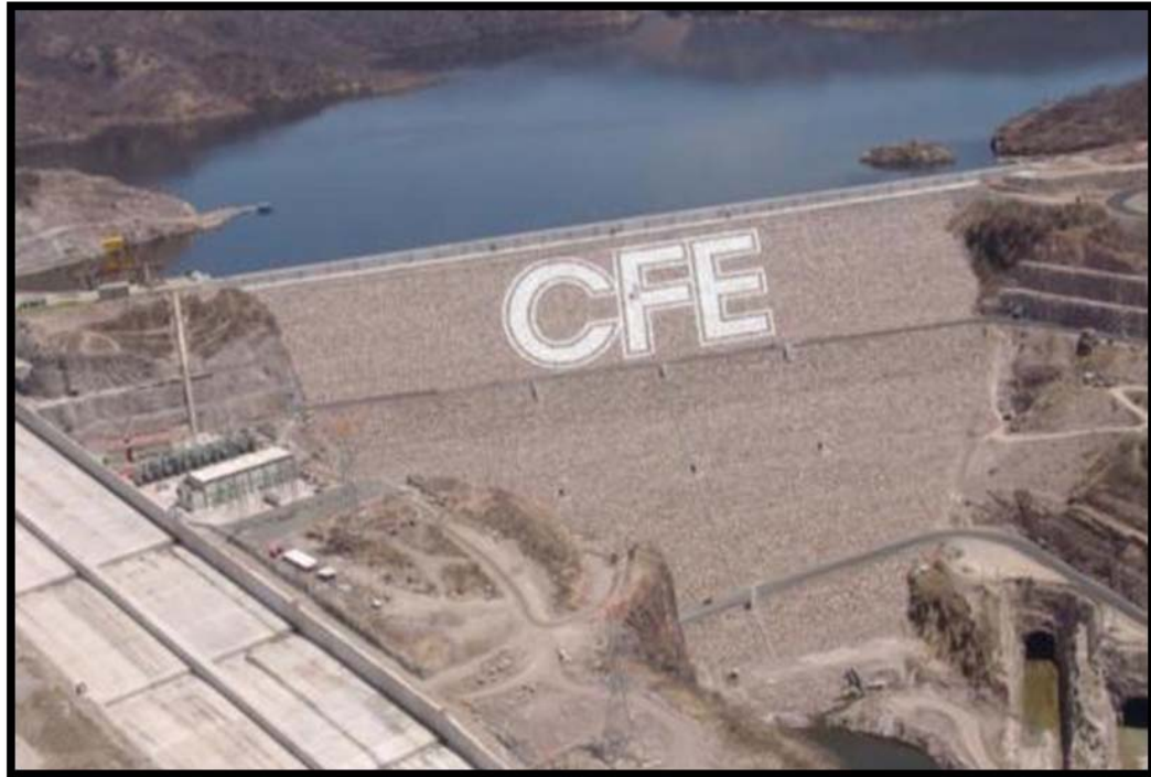
Figura 3.22. Cortina del Proyecto Hidroeléctrico El Cajón, Nayarit.
