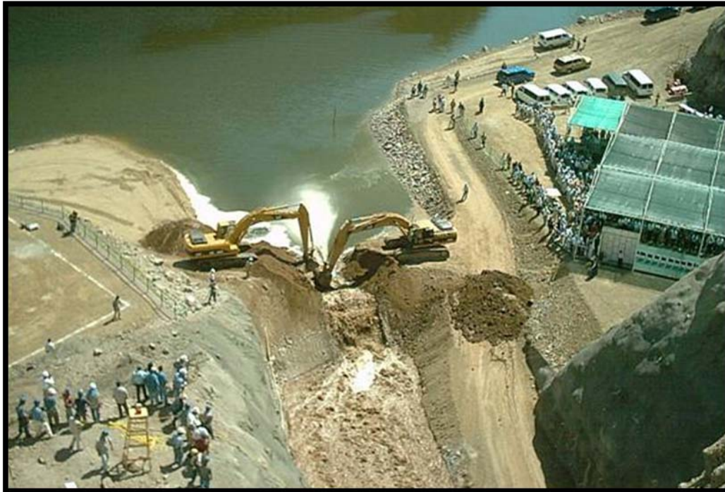
Figura 3.20. Desvío del río Santiago por los Túnel No.1, marzo del 2004.
