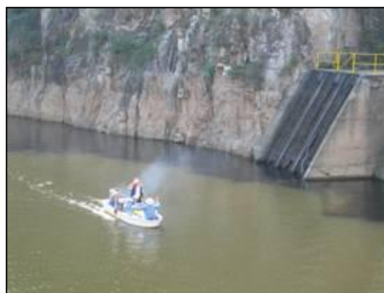
Figura 1-7 Trabajos realizados en el embalse
