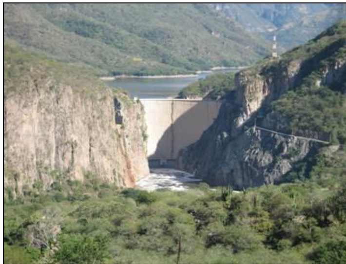
Figura 1-4 Vista panorámica de la Presa Santa Rosa, Jal.
