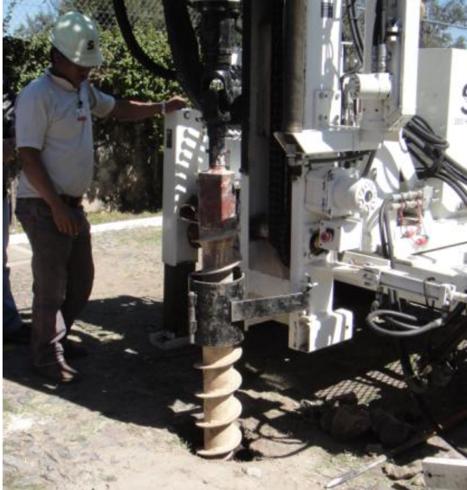
Figura 3.1: Perforación del sondeo
