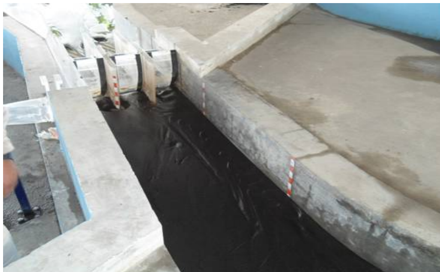
Figura 4.10 Funcionamiento del desarenador, arrastre de sedimento después de 2,23 hrs de prototipo, gasto 458 m 3 /s.
