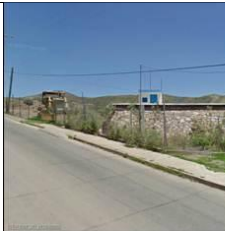
Figura 4.21 Tanque Las Teresas
