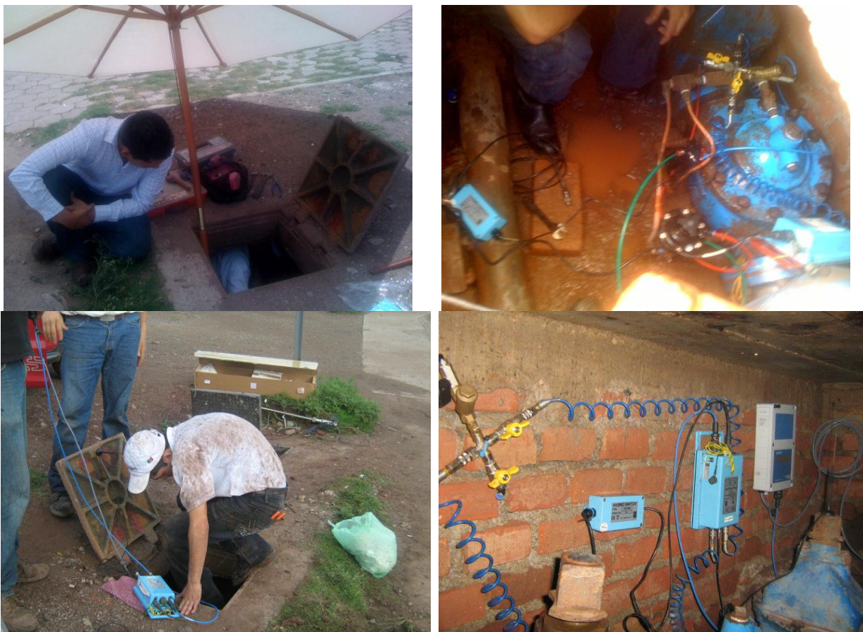
Figura 5.7 Instalación del controlador inteligente
