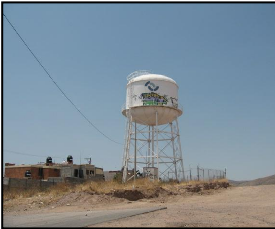
Figura 4.125 Tanque Ex Hda. Sta. Teresa
