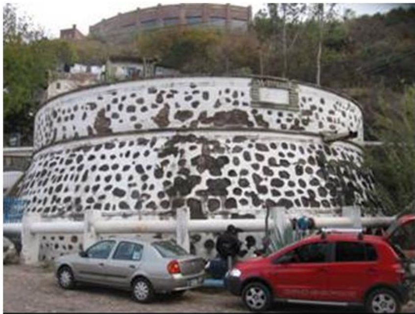
Figura 1.1 Vista actual del Tanque “El Venado”
