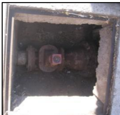
Figura 4.117 Detalle tubería LT-C-2
