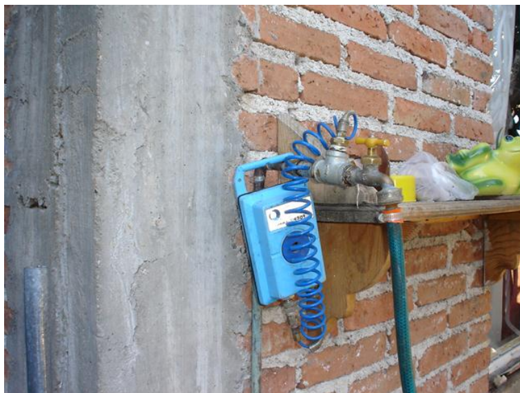
Figura 3.5 Medición de presión con Data logger en toma domiciliaria
