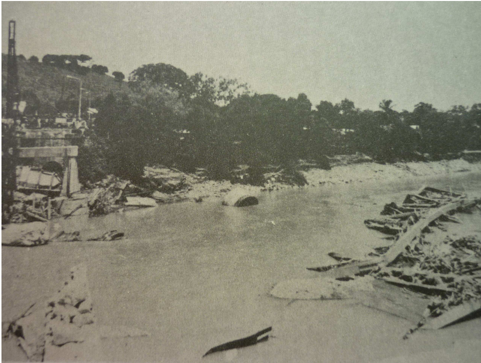
Figura 3.2 Foto del puente caído después de la avenida
