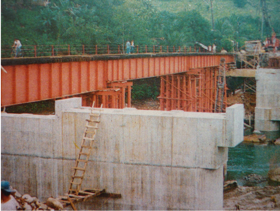
Figura 3.9 Construcción de pilas y estribos
