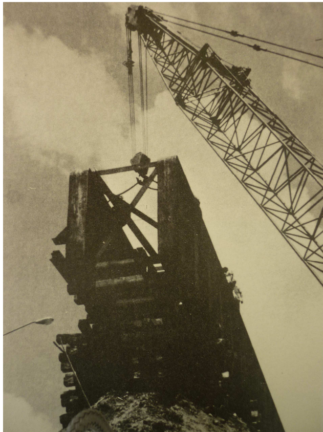
Figura 3.4 Pluma utilizada para colocar el puente provisional
