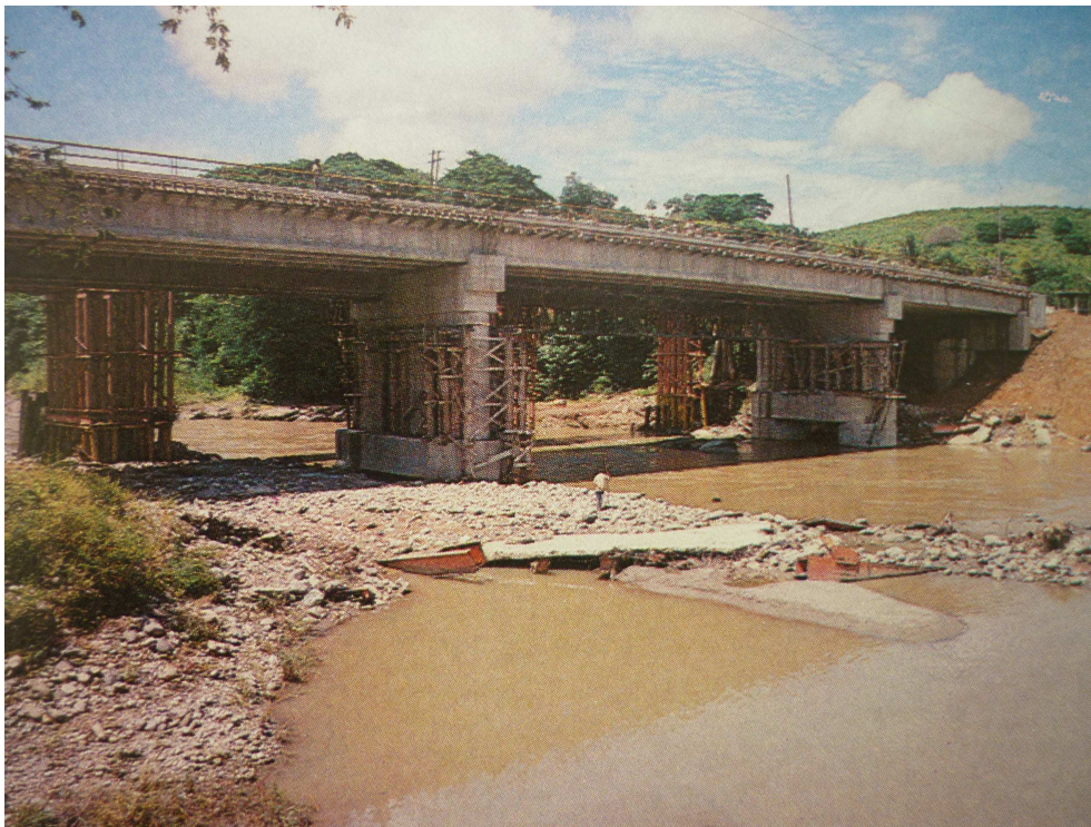
Figura 3.10 Traveses de concreto pretensado para tránsito carretero
