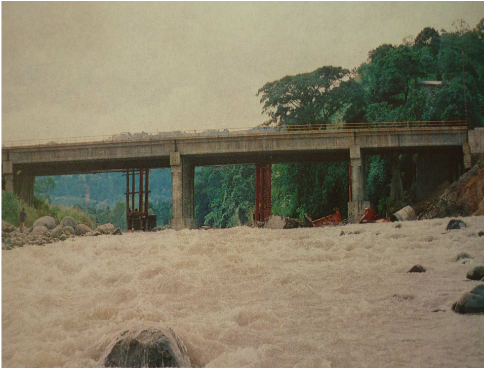
Figura 3.12 Puente "Teapa" terminado
