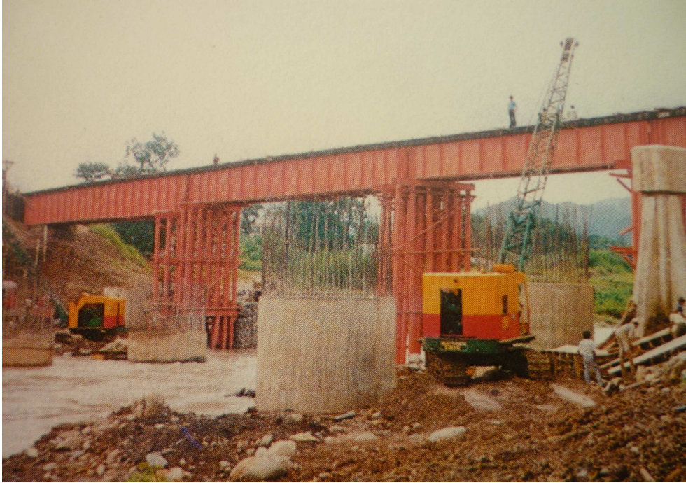
Figura 3.7 Construcción de cilindros
