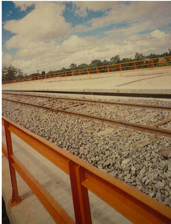
Figura 3.11 Vía ferroviaria terminada
