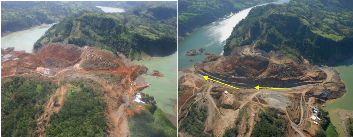
Figura 4.5 Vista aérea del caído Juan del Grijalva (izquierda). Panorámica del canal (derecha).
