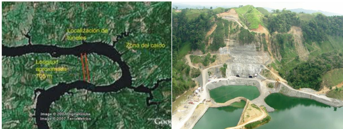
Figura 4.6 Ubicación de los túneles en Juan del Grijalva.
