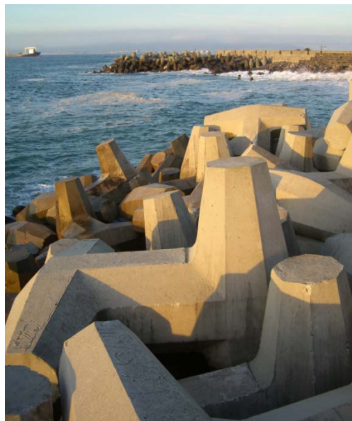
Figura 2. 14. Estructuras tipo “Dolos”.
