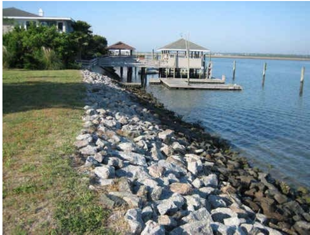
Figura 1. 12. Revestimiento de playa, utilizando material rocoso.
