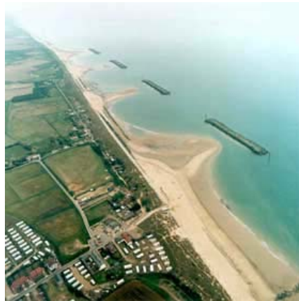
Figura 1. 7. Estructuras rompeolas y las salientes generadas.
