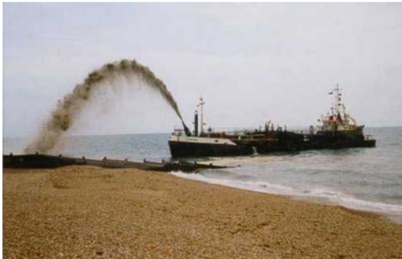
Figura 1. 4. Relleno de playa por bombeo de arena.
