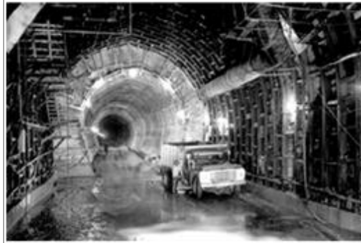
Figura 1.7 Túnel Emisor Poniente.
