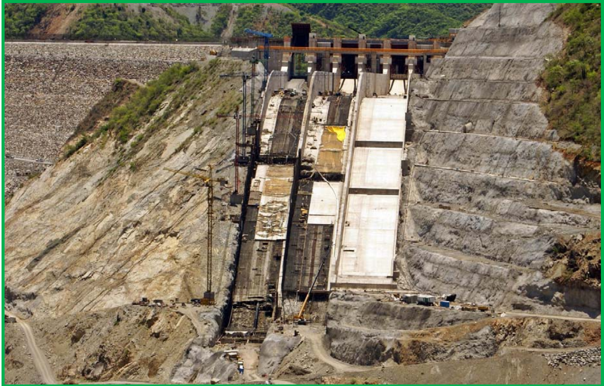
Foto 2.1 Vista Frontal del Avance de la construcción de la obra de Excedencias del P.H. La Yesca (Fuente CFE)
