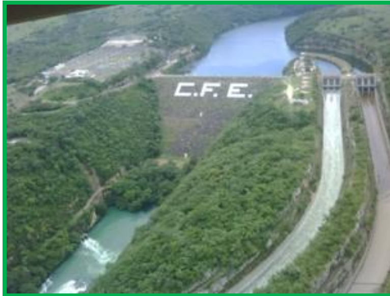
Figura 1.2. Proyecto Hidroeléctrico Belisario Domínguez "La Angostura" (Venustiano Carranza, Chiapas, Comisión Federal de Electricidad)
