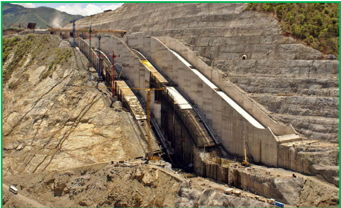
Foto 2.2 Vista Isométrica del Avance de la construcción de la obra de Excedencias del P.H. La Yesca (Fuente CFE)
