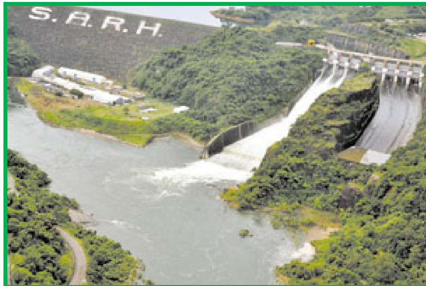
Figura 1.3. Proyecto Hidroeléctrico Ángel Albino Corzo "Peñitas" (Ostuacán, Chiapas, Secretaría de Agricultura y Recursos Hidráulicos)
