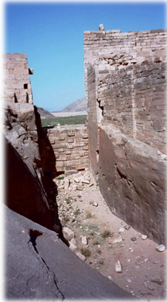
Figura 2.2 Vertedor de la antigua presa de Marib.
