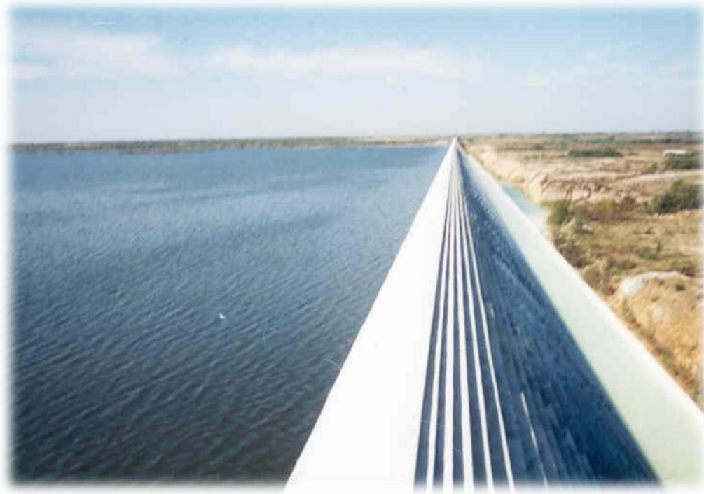
Figura 2.12 Cimacio de la Presa Derivadora “Las Blancas” en Tamaulipas. (CNA)
