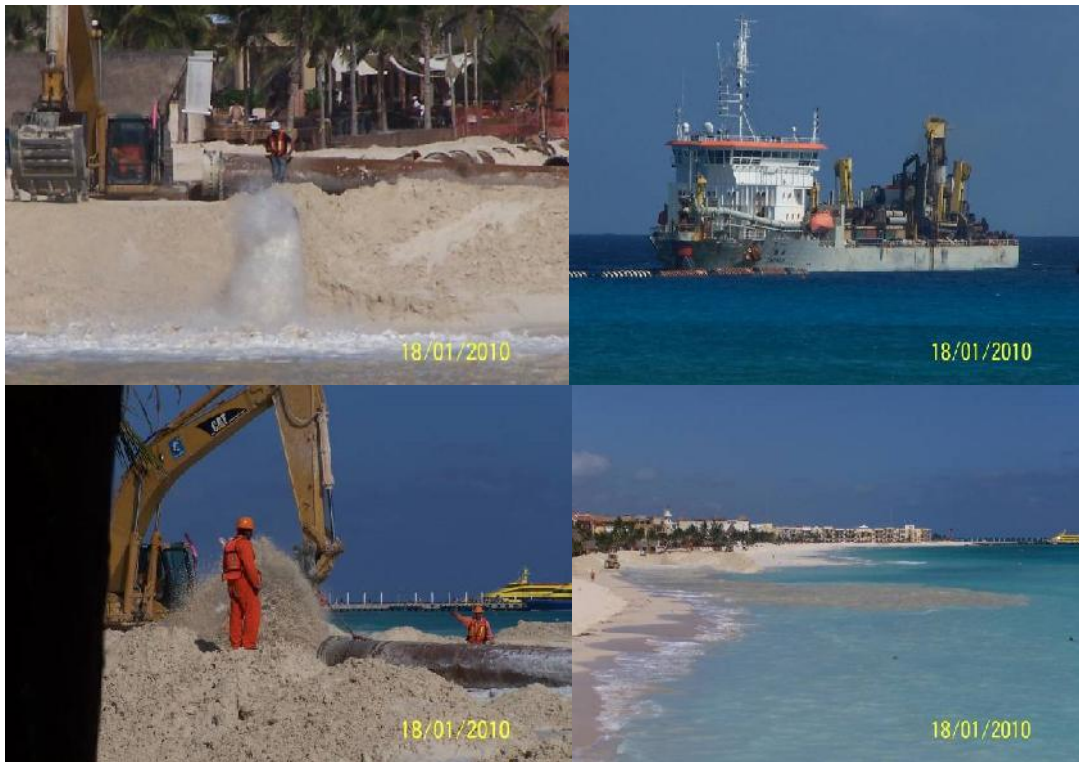
Fig.4.32 Fotografías de las actividades de vertido en las playas de la zona hotelera de Cancún. El límite del vertido se ubicó a la altura del Hotel Royal Solaris a aproximadamente 1.5 Km al Norte de Punta Nizuc. Vertido de la draga KAISHUU. Imagen tomada por personal de la UNAM en el proyecto de restauración.
