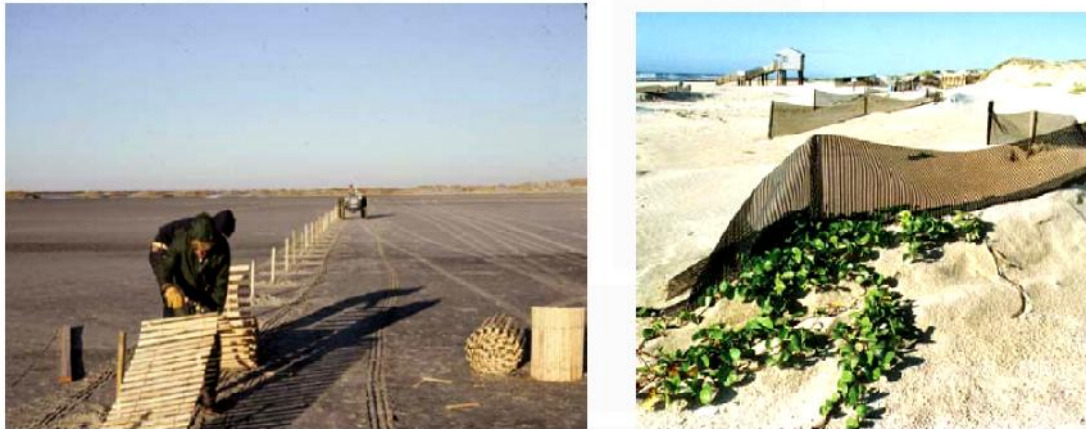
Fig. 3.7. Ejemplo de vallas de madera y textiles para la construcción de dunas
