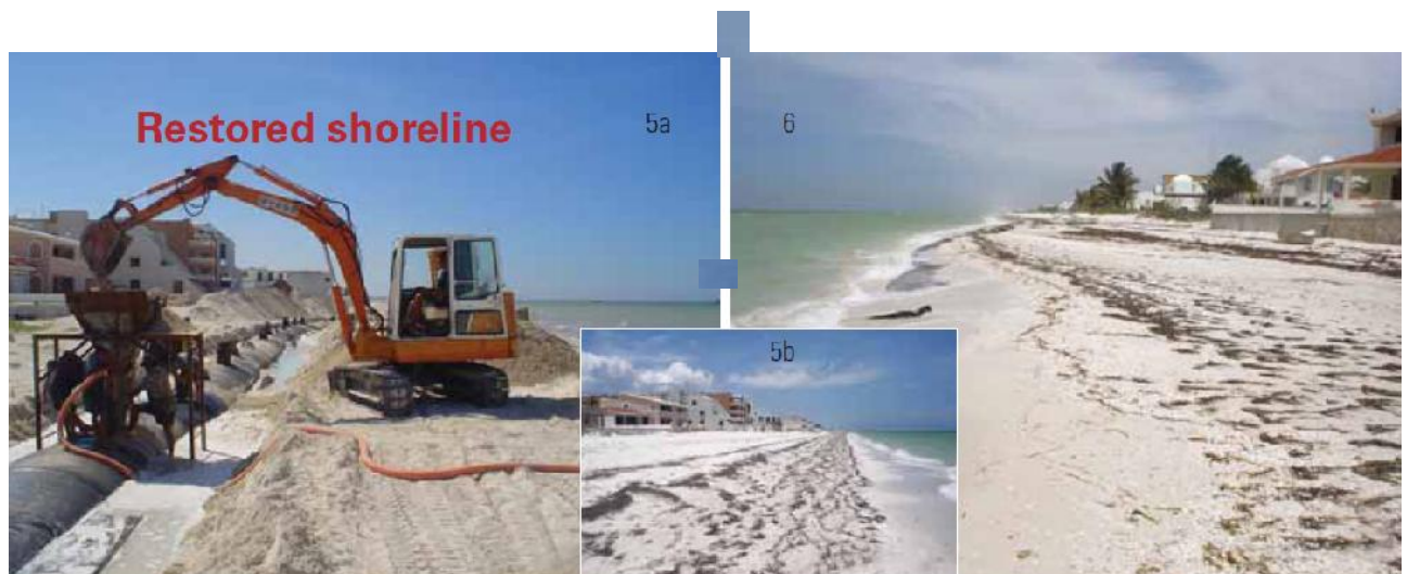
Fig. 1.7. Restauración de la línea de playa después de ocho meses colocado el geotubo. Fuente: Goesynthetics volumen junio/julio 2006
