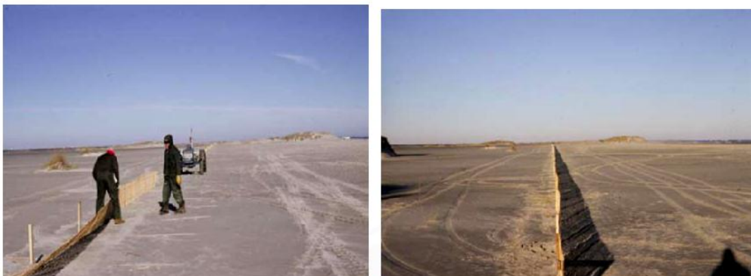
Fig.3.8 Colocación y posicionamiento de vallas para la formación de dunas costeras
