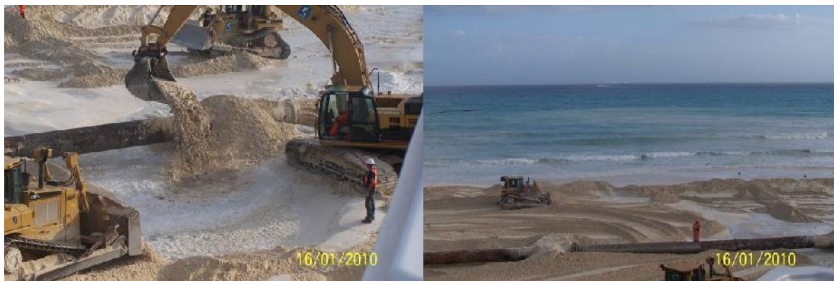
Fig.4.34 Actividades de vertido en Playa del Carmen, entre la Terminal Marítima y el muelle de ultramar (a la altura del hotel 10 & The Beach). El vertido de la draga KAISHUU inicio a 800 m al sur del muelle de la Av. Constituyentes en Playa del Carmen. Imagen tomada por personal de la UNAM en el proyecto de restauración.
