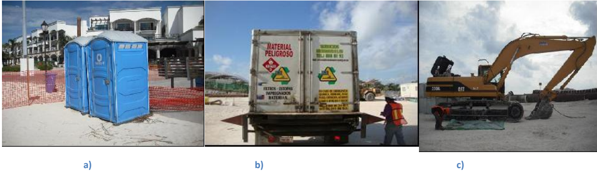
Fig.4.36 a) Sanitarios en playa, b) Manejo de residuos peligrosos, c) Mantenimiento de maquinaria en playa uso de equipo anti derrame. Fotografías tomadas por personal de CFE.
