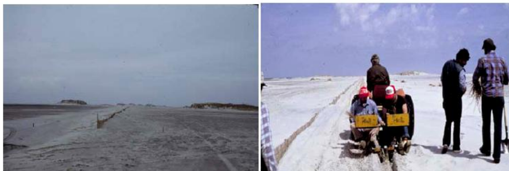
Fig. 3.10. Formación de dunas costeras, y sembrado de pastizales para ofrecer estabilidad
