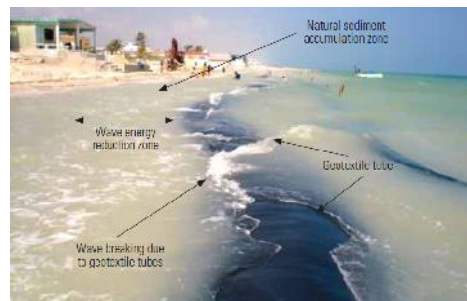
Fig. 1.6.Tubos geotextiles ,reduccion de la energía de la ola. Fuente: Goesynthetics volumen junio/julio 2006
