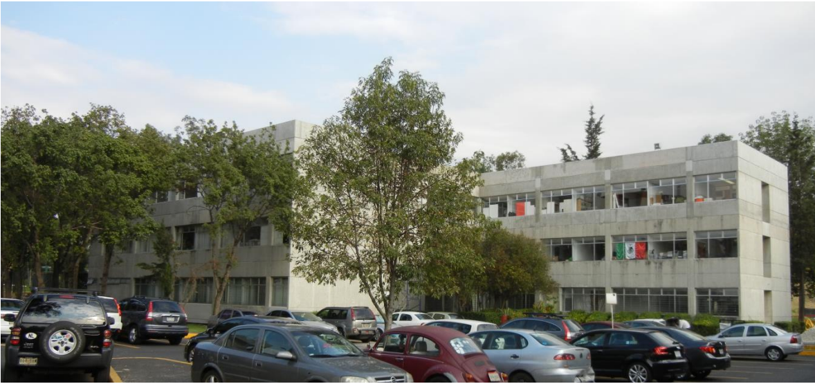
Figura 4-55 Fotografía del edificio ya construido
