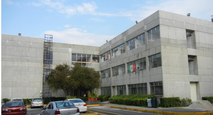
Figura 4-57 Edificio ya construido
