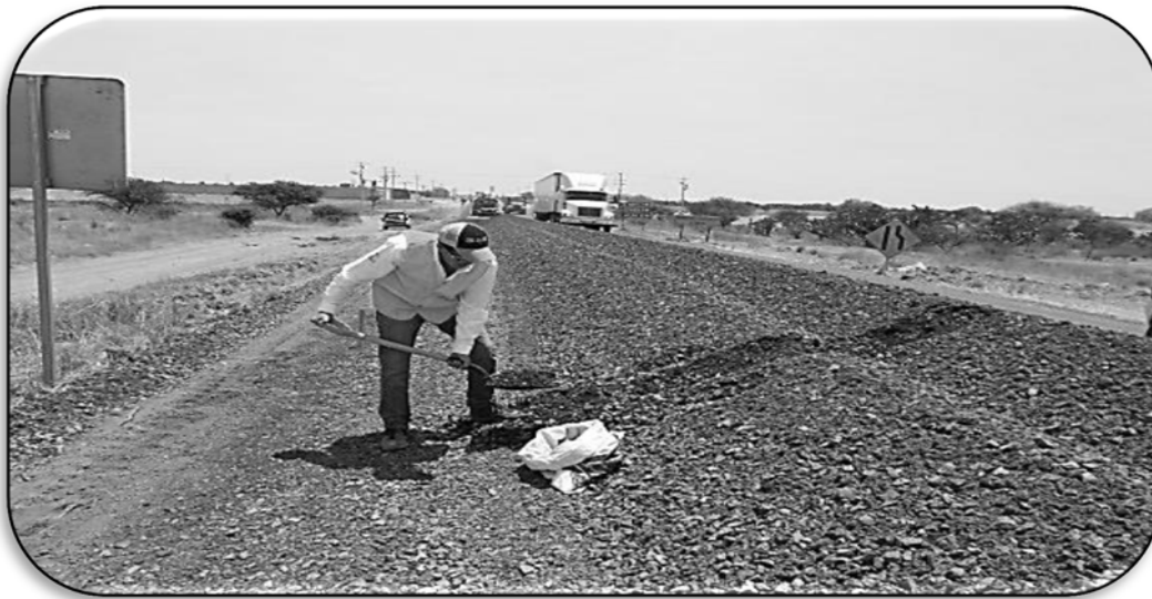
Fig. 6.2 Personal de laboratorio en trabajos de verificación de la mezcla de material de recuperación para base de pavimento.
