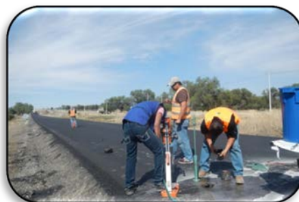
Fig. 6.7.2 Corte y Extracción de Muestra de Carpeta Asfáltica.
