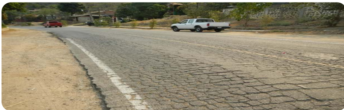
Fig. 1.2.2 Falla en superficie de rodamiento.
