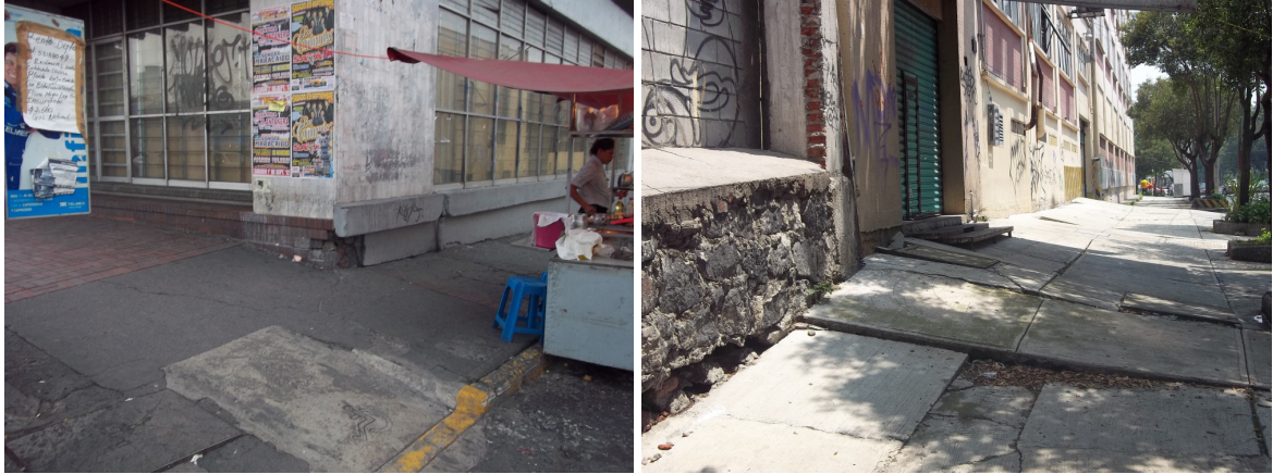
Figura B.1.57. Emersión aparente de estructuras sobrecompensadas
