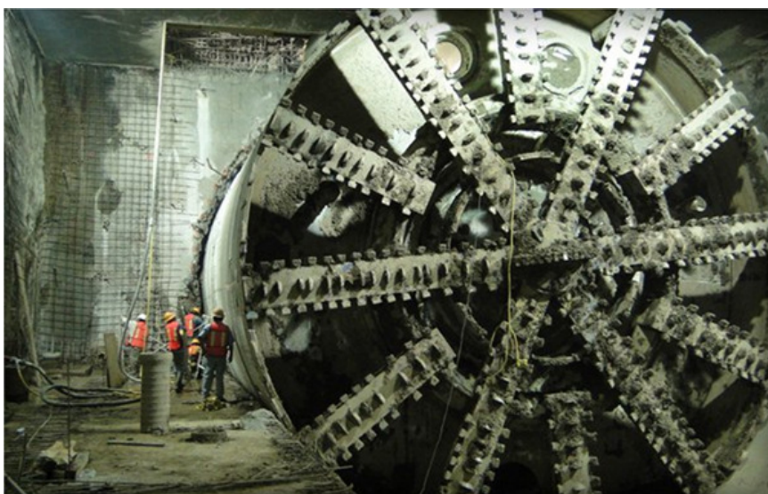
Figura B.1.15 Escudo de presión de tierras balanceadas (EPB) empleado para la construcción de la Línea 12 del STCM de la ciudad de México
