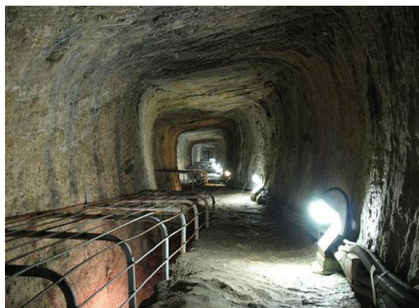
Figura B.1.2 Túnel para conducción de agua construido por los griegos en la Isla de Samos en el S. VI a.C
