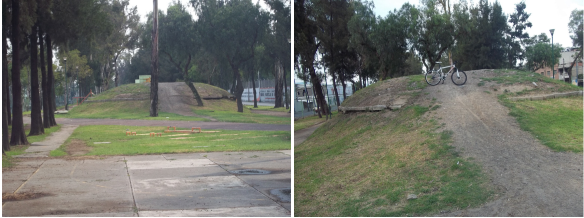
Figura B.1.33. Caso de emersión aparente ocasionada por el fenómeno de hundimiento regional en lumbreras construidas en la ciudad de México
